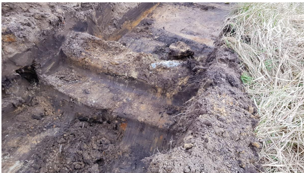
Figuur 21. Asbest riolering, ter hoogte van verkennende boring 5 waarbinnen silex werd aangetroffen
