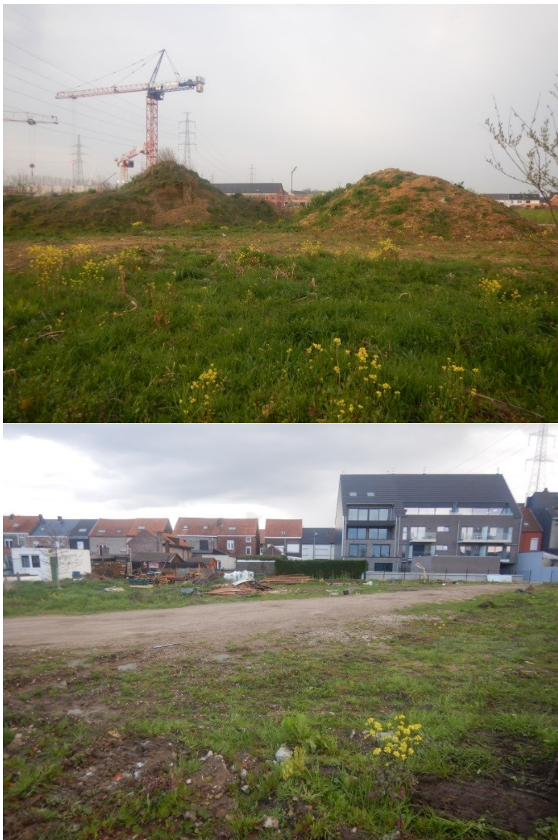
Figuur 5: Situatie op het terrein (boven: hopen aarde; onder: aarden weg en opgeslagen materiaal)
