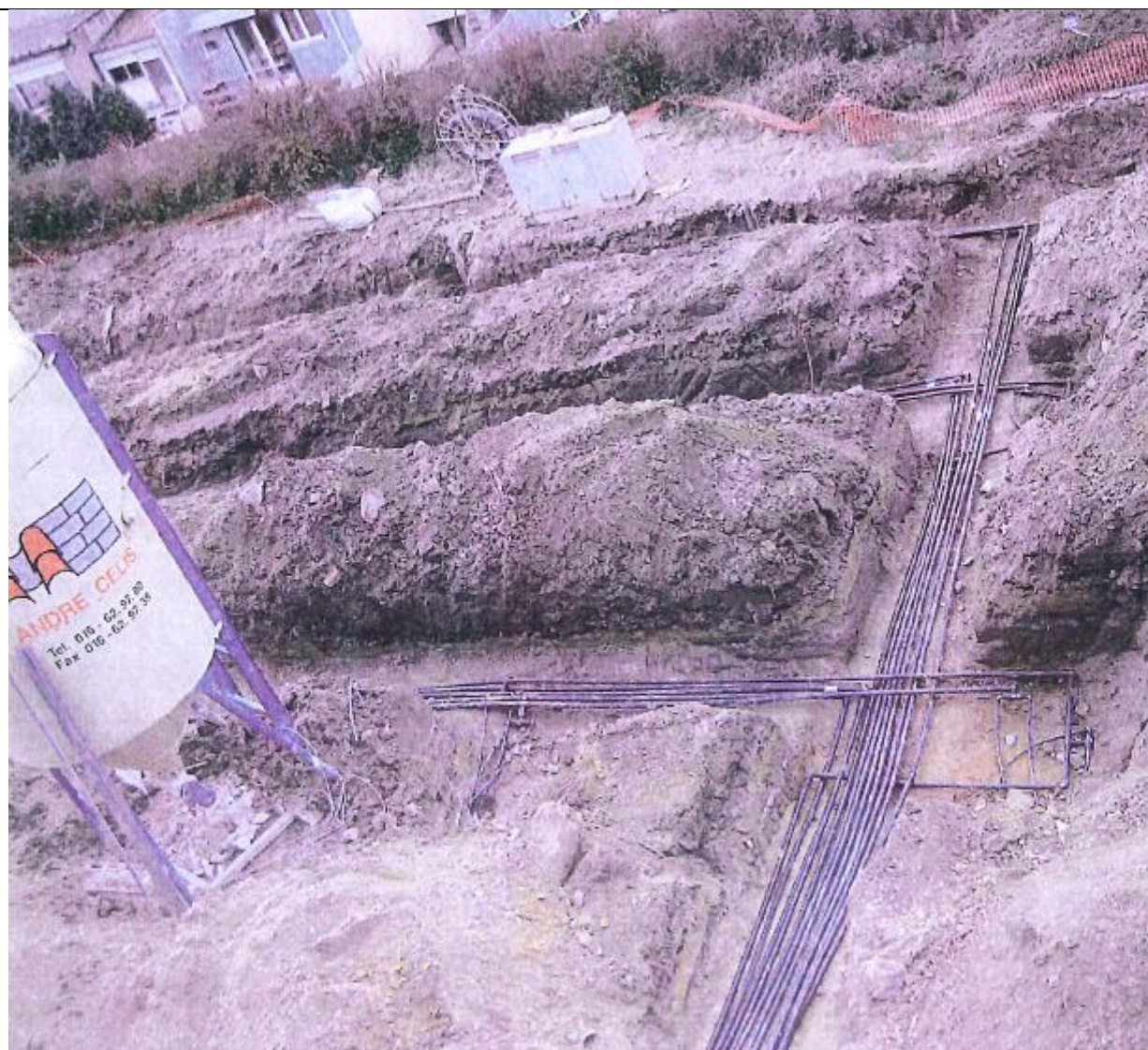
Figuur 20. Foto aanleg BEO-veld
