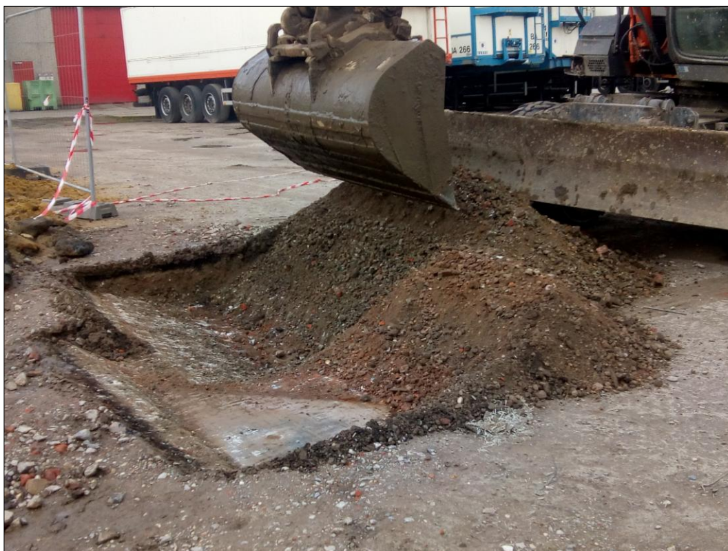
Afb. 19. Het aanleggen van één van de profielgaten tijdens fase 2, op het parkeerterrein voor vrachtauto's.
