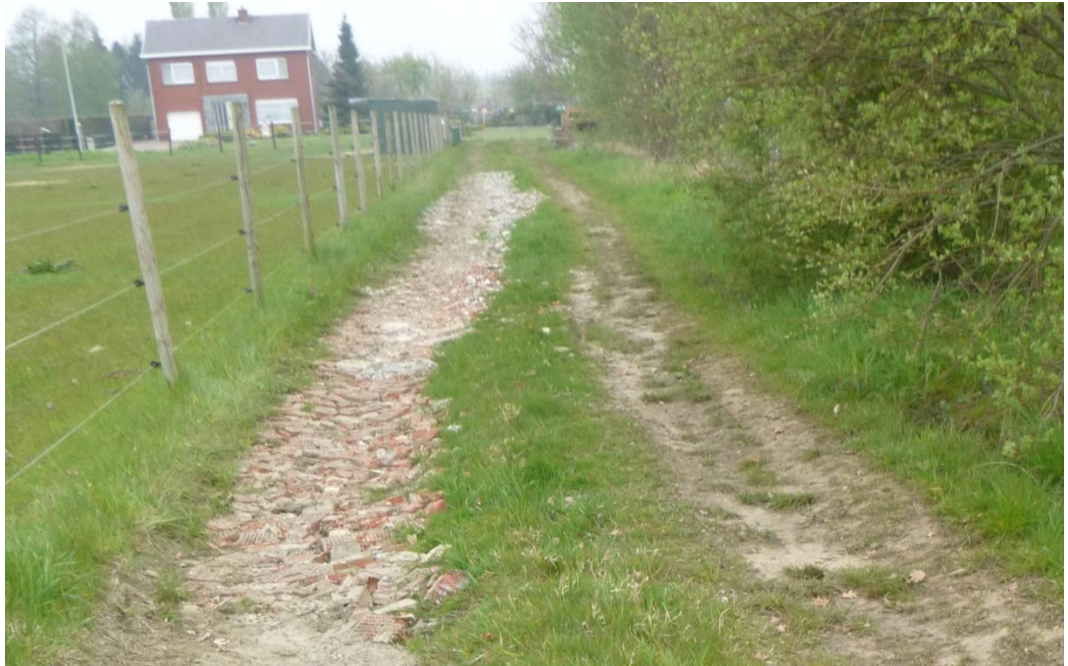
Afb. 15. Pad verhard met puinmateriaal.
