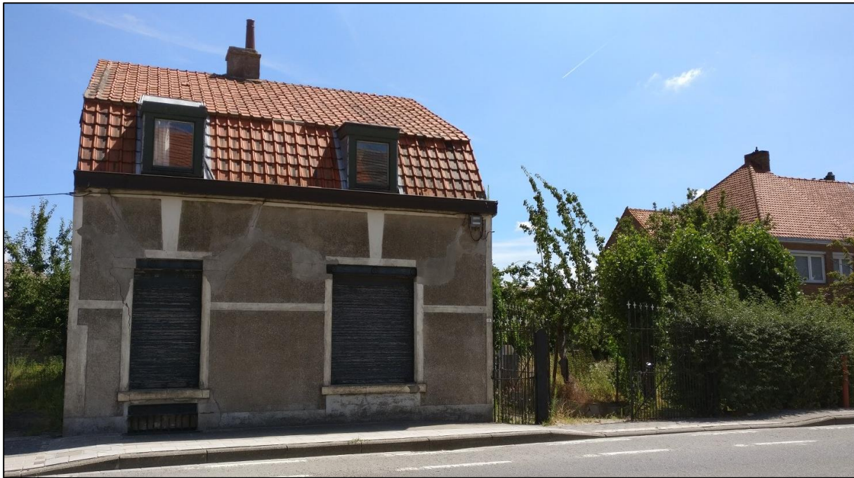
Figuur 5: Foto van het terrein genomen vanuit de Pelikaanstraat (lokalisering foto 2 op plan bestaande toestand).
