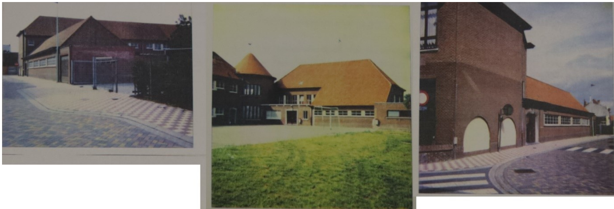
Fig. 11. Foto's van de bestaande toestand in 1990 (1990/368).
