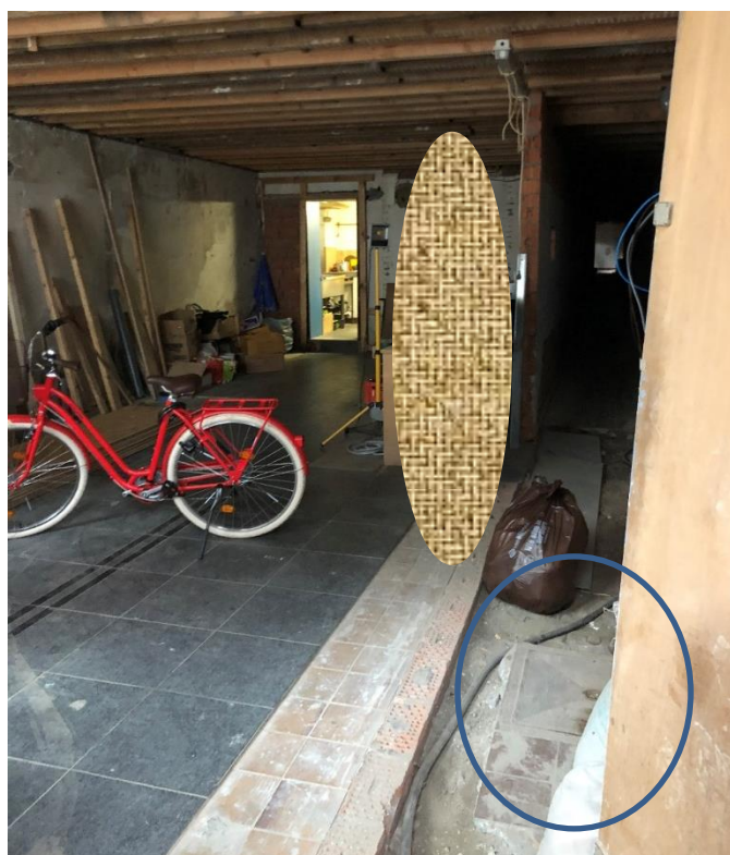
F2 zicht op huidige toestand Langestraat 85: nieuwe nutsleidingen in smalle doorgang en tegelvloer bovenop bestaande vloer; aanwezige niveauverschillen
