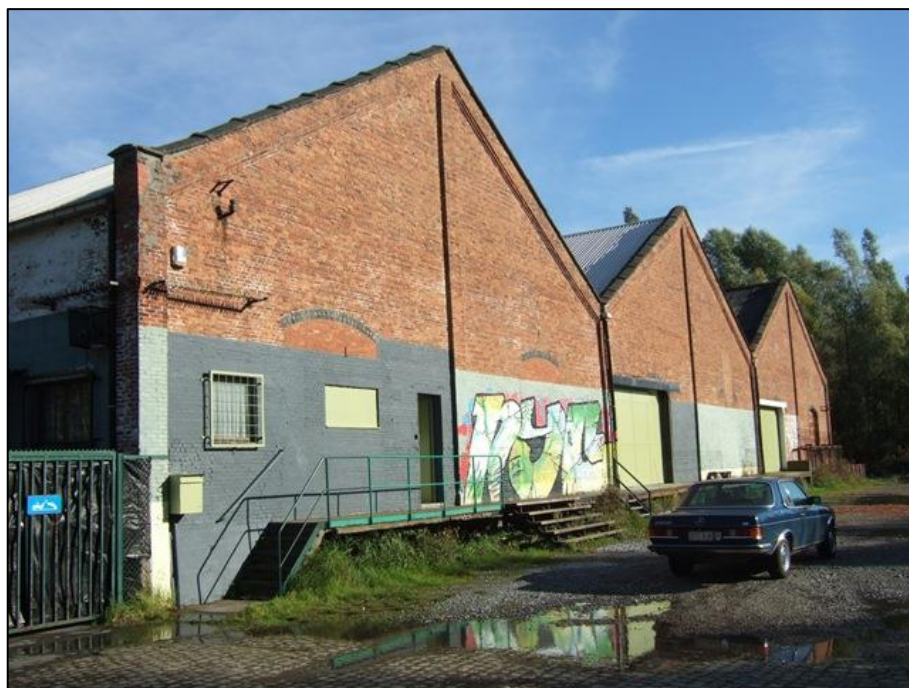
Figuur 27: Werkplaats American Petroleum Company (ID: 213460). (Bron: Inventaris Onroerend Erfgoed 2016)
