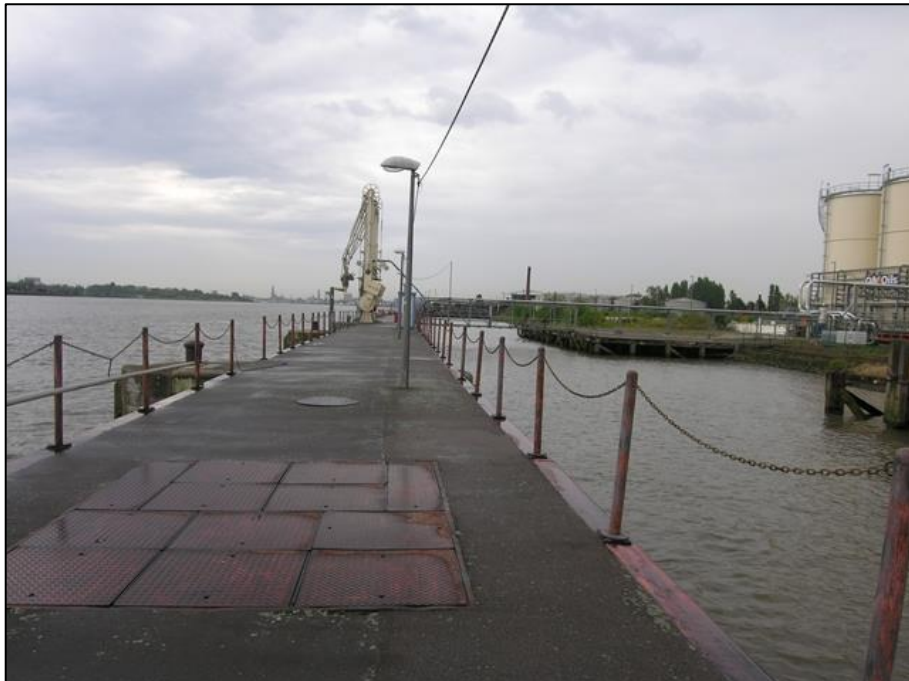
Figuur 32: Petroleumpier (ID: 213459). (Bron: Inventaris Onroerend Erfgoed)
