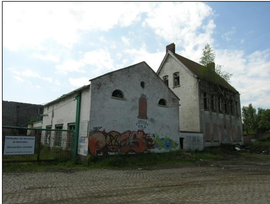
Figuur 26: Bedrijfsgebouwen American Petroleum Company. (Bron: Inventaris Onroerend Erfgoed 2016)
