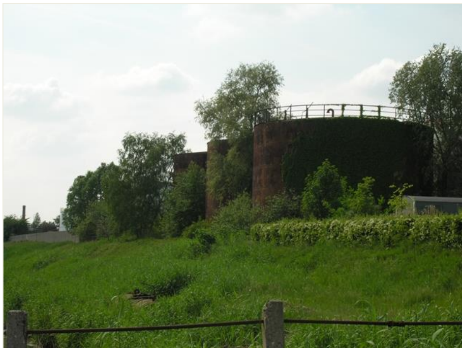
Figuur 30: Geklinknagelde tanks (ID: 213479). (Bron: Inventaris Onroerend Erfgoed)
