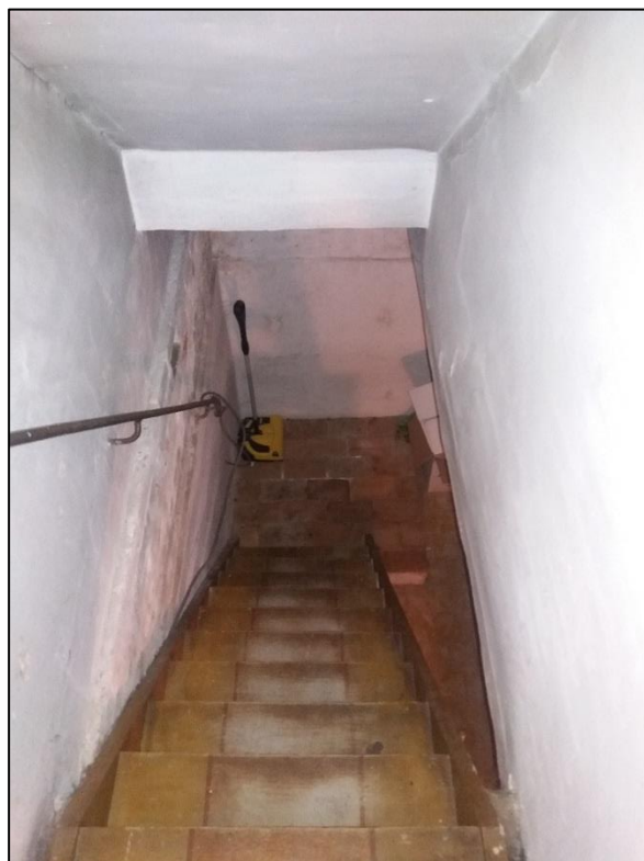
Figuur 8: Foto van de trap naar de kelder (Beervelde Baan 47) (ABO nv 2019)
