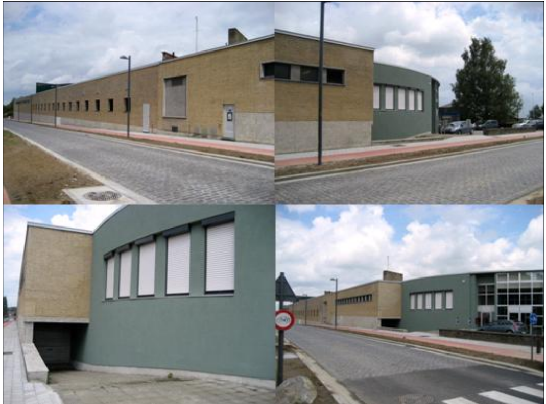
Afb. 5. Huidige toestand van het plangebied, foto's opdrachtgever. Linksboven: straatzijde richting hoek Relegemsestraat met Schapenbaan. Rechtsboven: einde plangebied Schapenbaan. Linksonder en rechtsonder: hoek Relegemsestraat met Schapenbaan.
