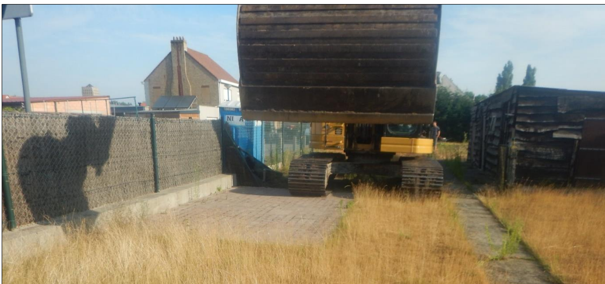
Figuur 30: Verhard terras, bijgebouw & afsluiting
