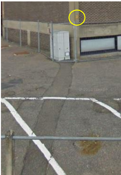
Fig. 21: aanduiding tegen de muur en spoor in het asfalt van gas- en elektriciteitsleidingen
