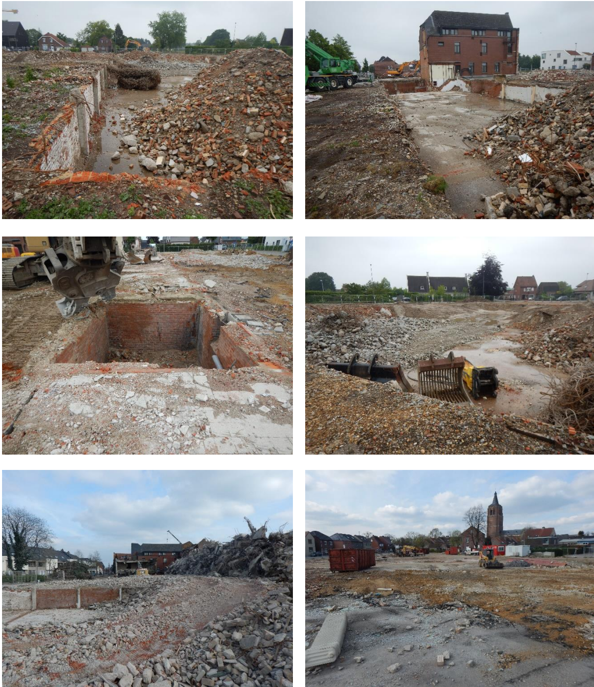
Fig. 31: kelders en bouwpuin na afbraak van de hoofdgebouwen op het centrale terreindeel
