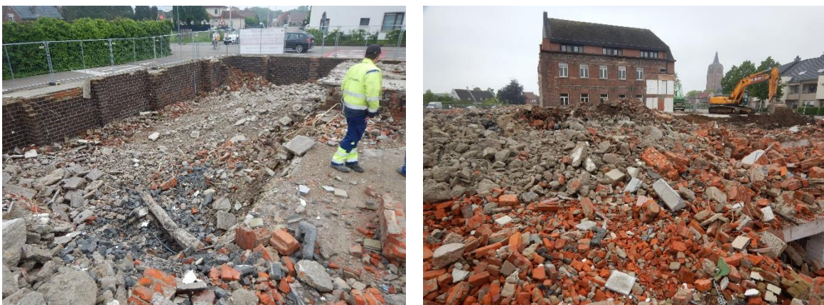
Fig. 30: de afbraakwerken en restanten van kelders en puin aan de oostzijde van het projectgebied, palend aan de “binnentuin”.
