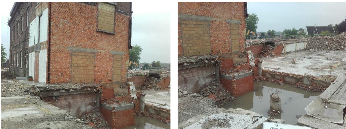
Fig. 29: de recent gebouwde en inmiddels afgebroken kelder op de noordzijde van het gebouw (muur) uit 1698.
