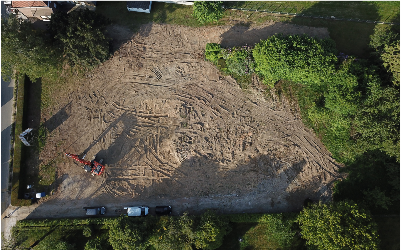
Figuur 7: Luchtfoto van de uitbraak van het voormalige gebouw en de te behouden oprit
