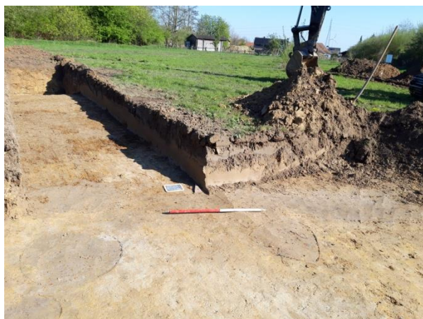
Figuur 8: aanleg van een kijkvenster ter hoogte van een greppel in sleuf 4.
