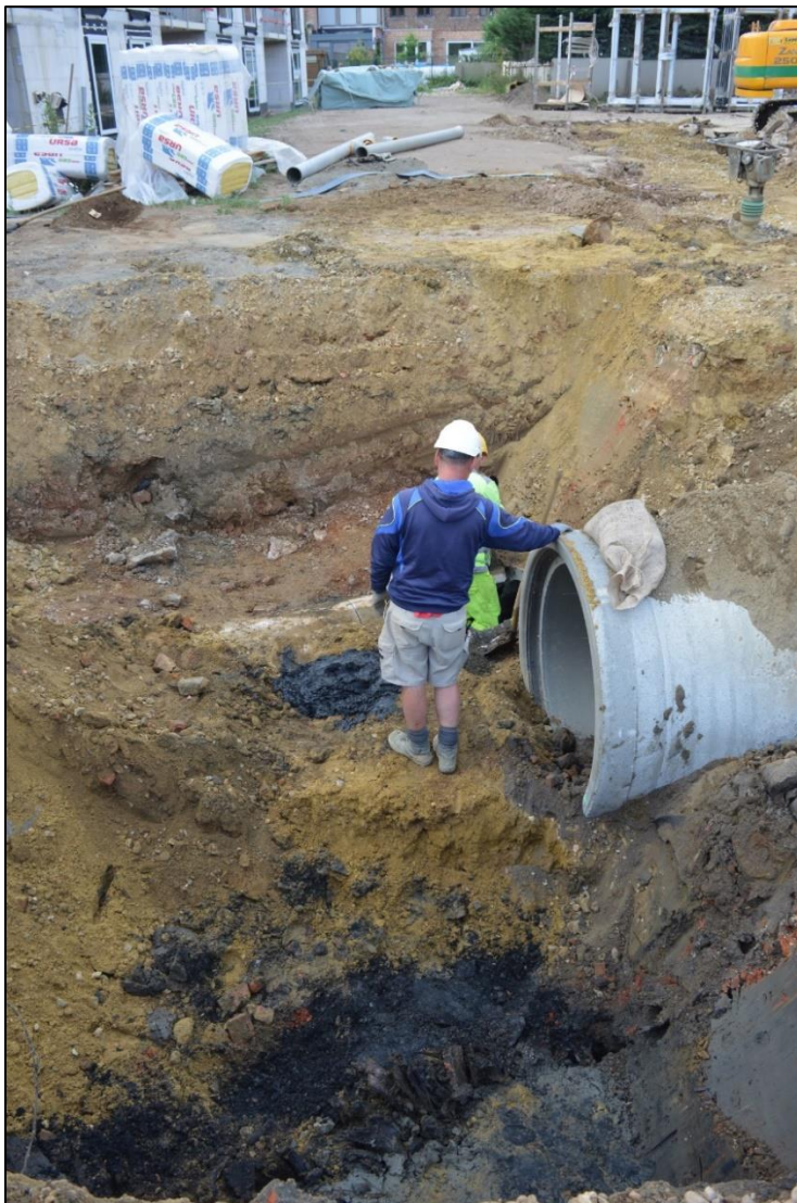
Afb. 56: Werkfoto oostelijk deel opvolging riolering met sterk geroerde bodem en aanwezigheid van de houten beschoeiing op aanzienlijke diepte (ca. 1,7 m tot 2 m diepte) (Bron ARON bvba, zomer 2015).
