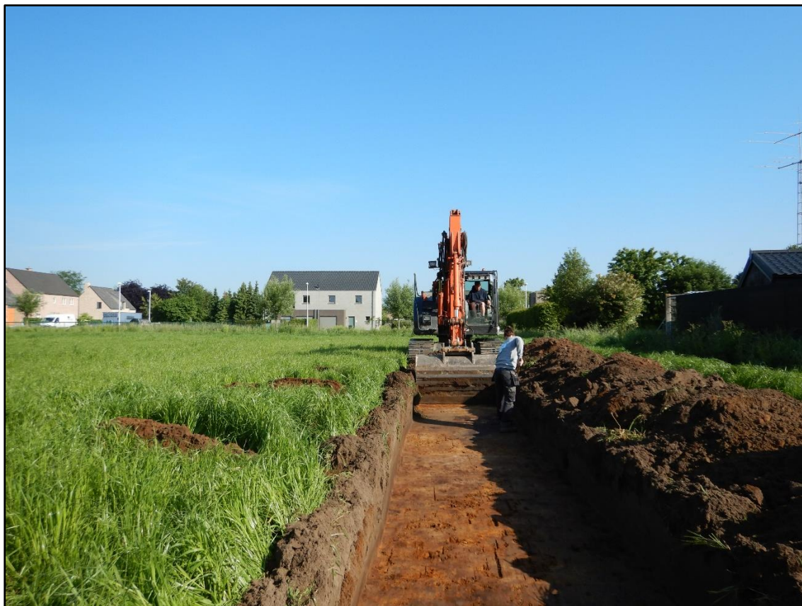
Figuur 6 Sfeerbeeld tijdens de aanleg van sleuf 1.
