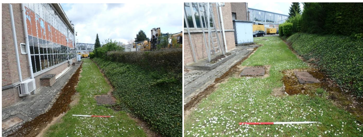
Figuur 16: Zicht op de zone ten oosten van het gebouw met aanwezige nutsleidingen, richting het noorden.
