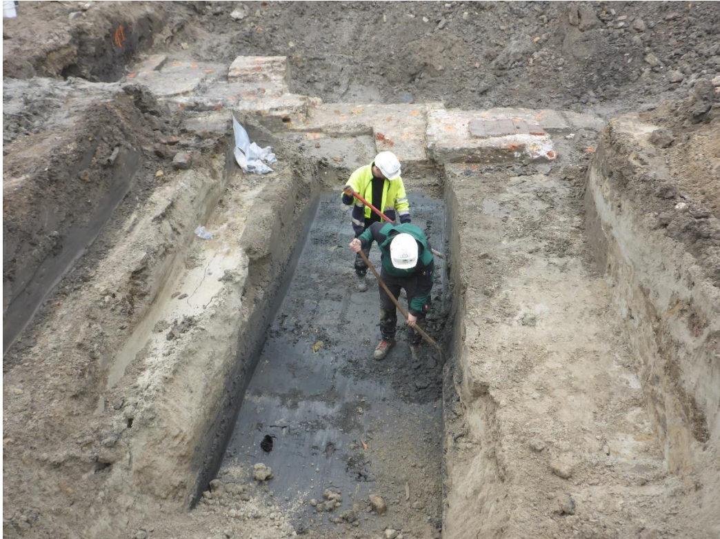
Figuur 13 De aanleg van werkput 3 (GATE)
