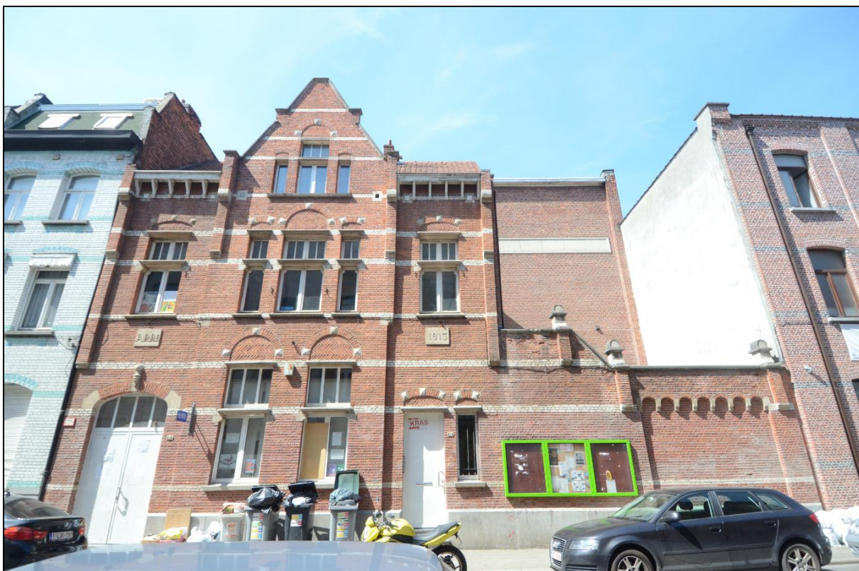
Figuur 8: Huidige situatie, schoolmeesterwoning, zicht vanuit het zuiden (Bron: initiatiefnemer).
