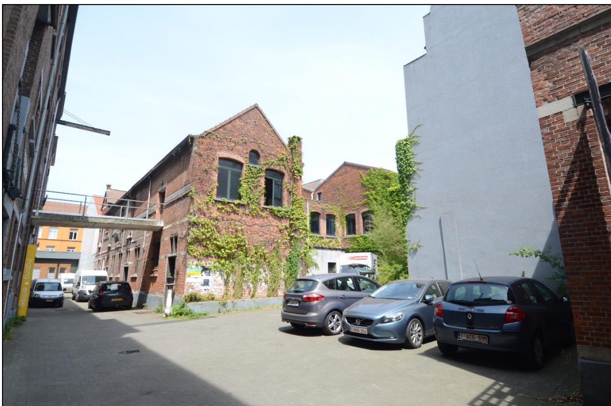
Figuur 9: Huidige situatie, westblok, zicht vanuit het zuidwesten (Bron: initiatiefnemer).
