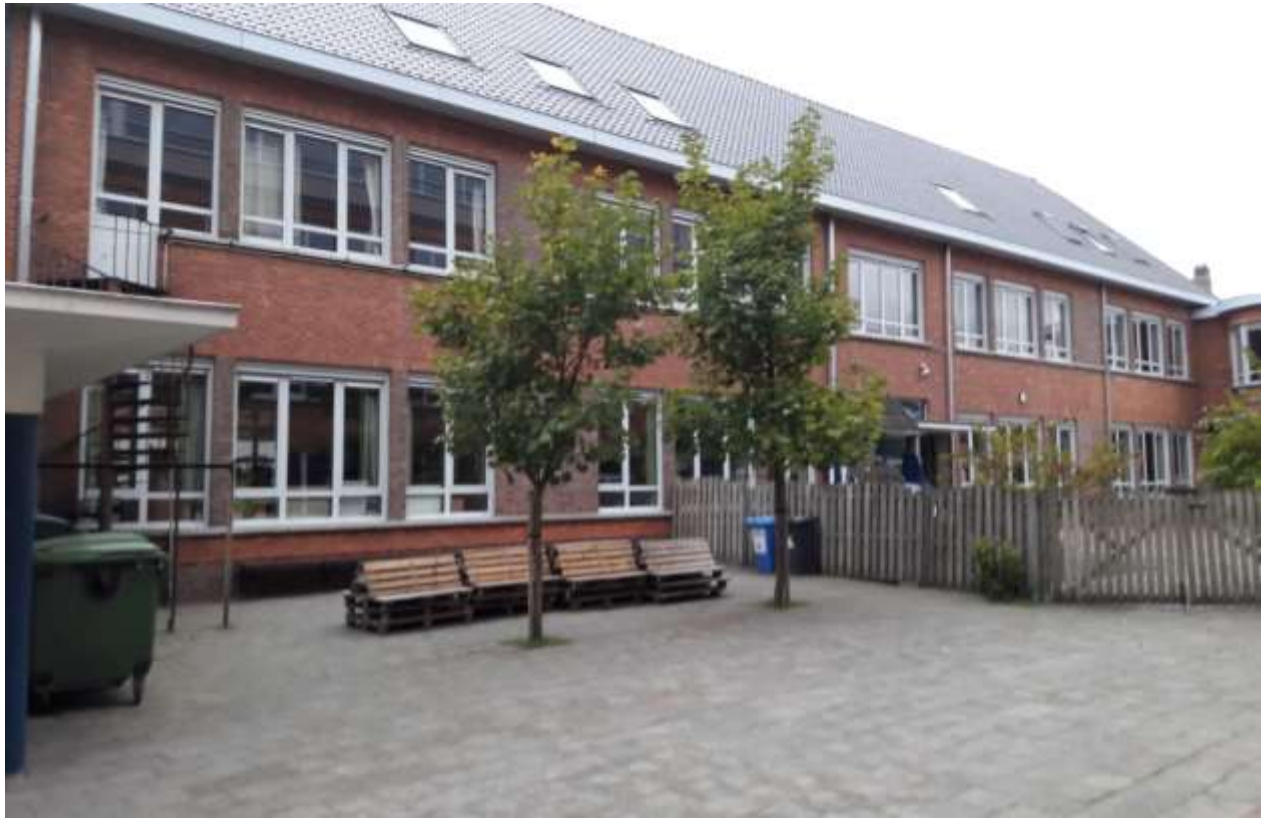
Figuur 4: bestaande toestand blok A
