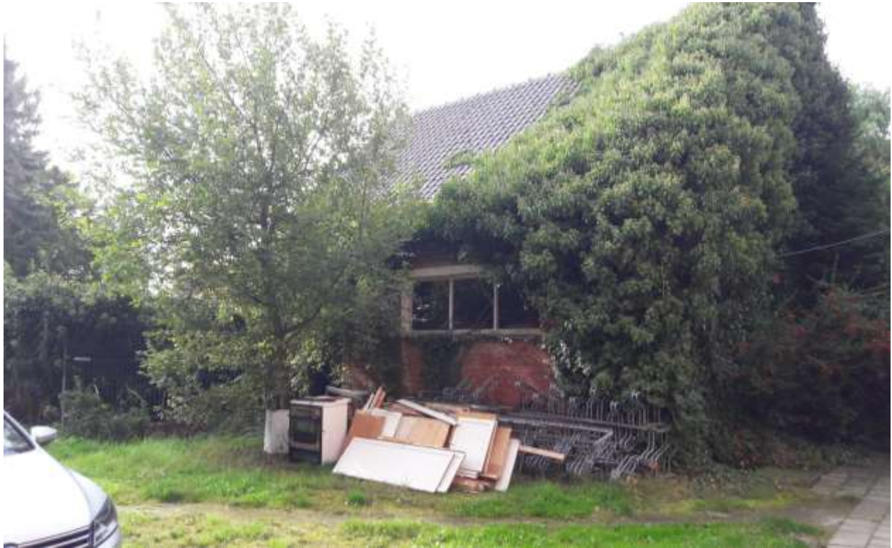
Figuur 8: bestaande toestand: te slopen washuis
