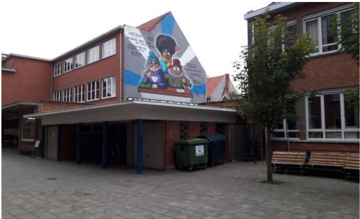
Figuur 5: bestaande toestand blok A
