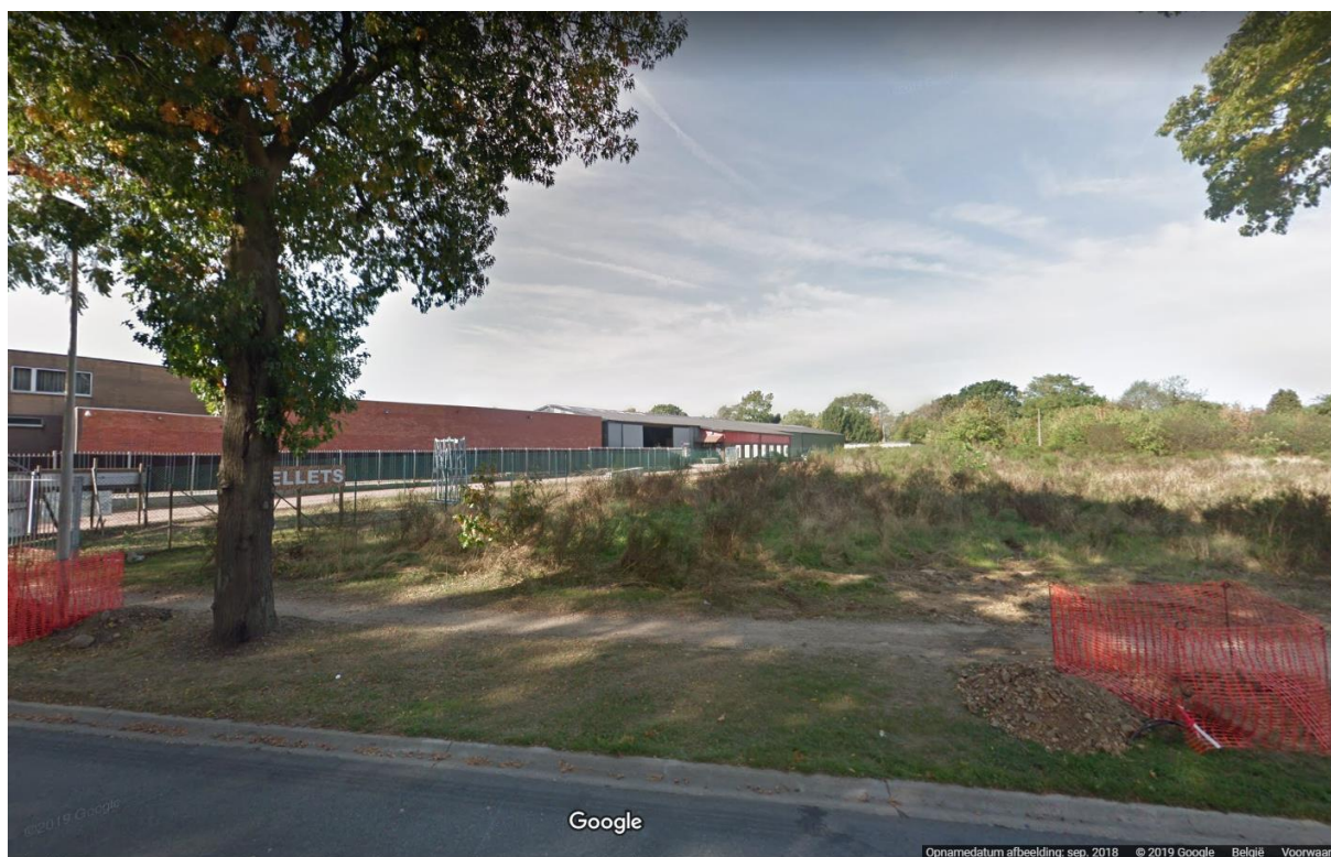
Figuur 3: Huidige situatie, gezien vanaf de Koninginnelaan
