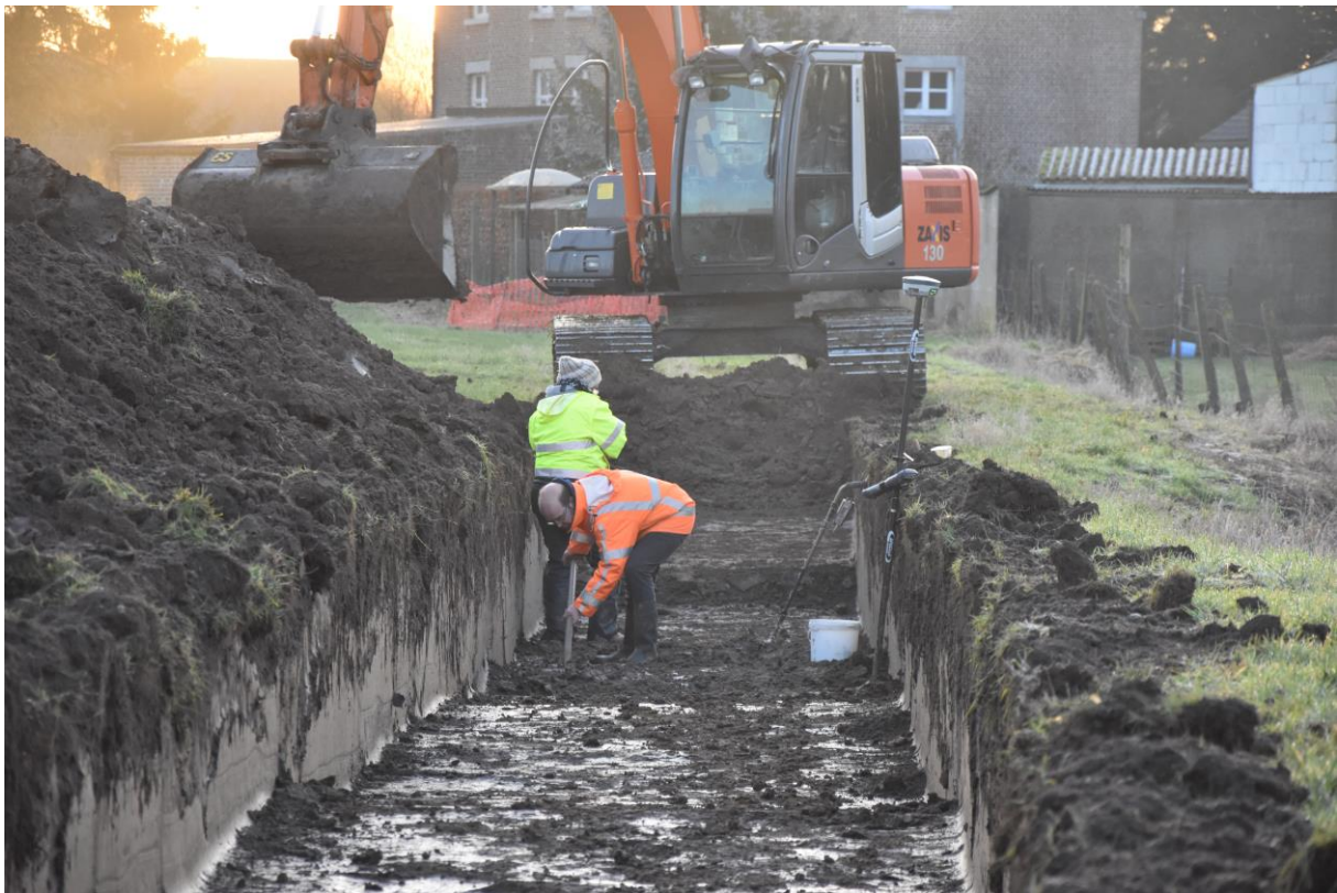
Fig. 1.4. Broekom-Lindestraat. Aanleg van het vlak.
