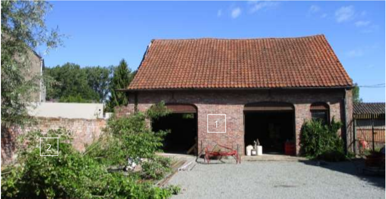
Figuur 6 Noordoostelijk bijgebouw (1 op figuur 4). Vermoedelijk 19de eeuwse kern maar sterk verbouwd en deels afgebroken (linkerzijde); maakt een hoek met bijgebouw in verlengde van het huis (2 op figuur 4). Ook afgebroken tot op manhoogte
