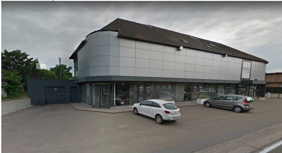
Figuur 26: Zicht op bestaande te slopen winkel aan de straatzijde
