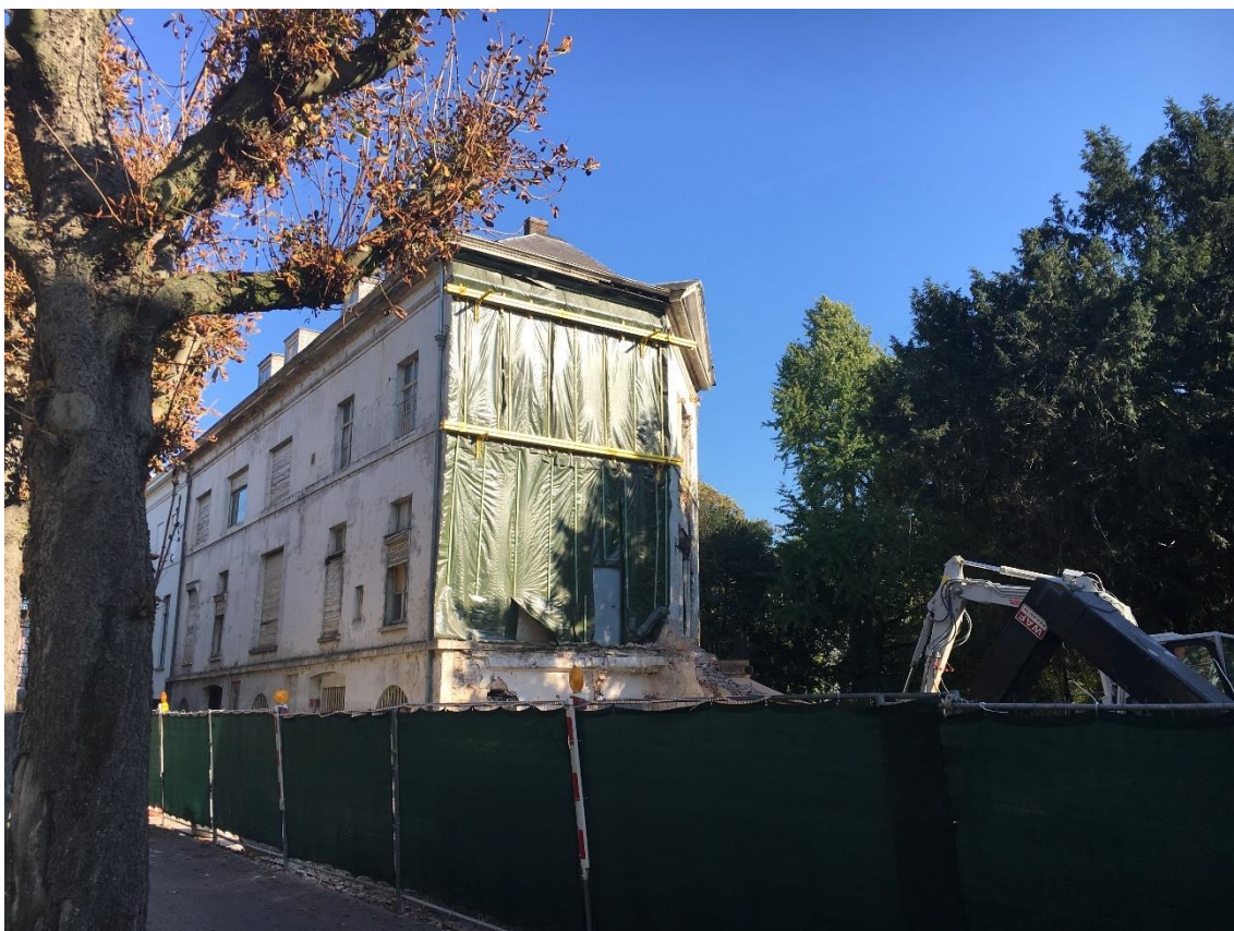
Figuur 4: Bestaande toestand van de zijgevel rechts
