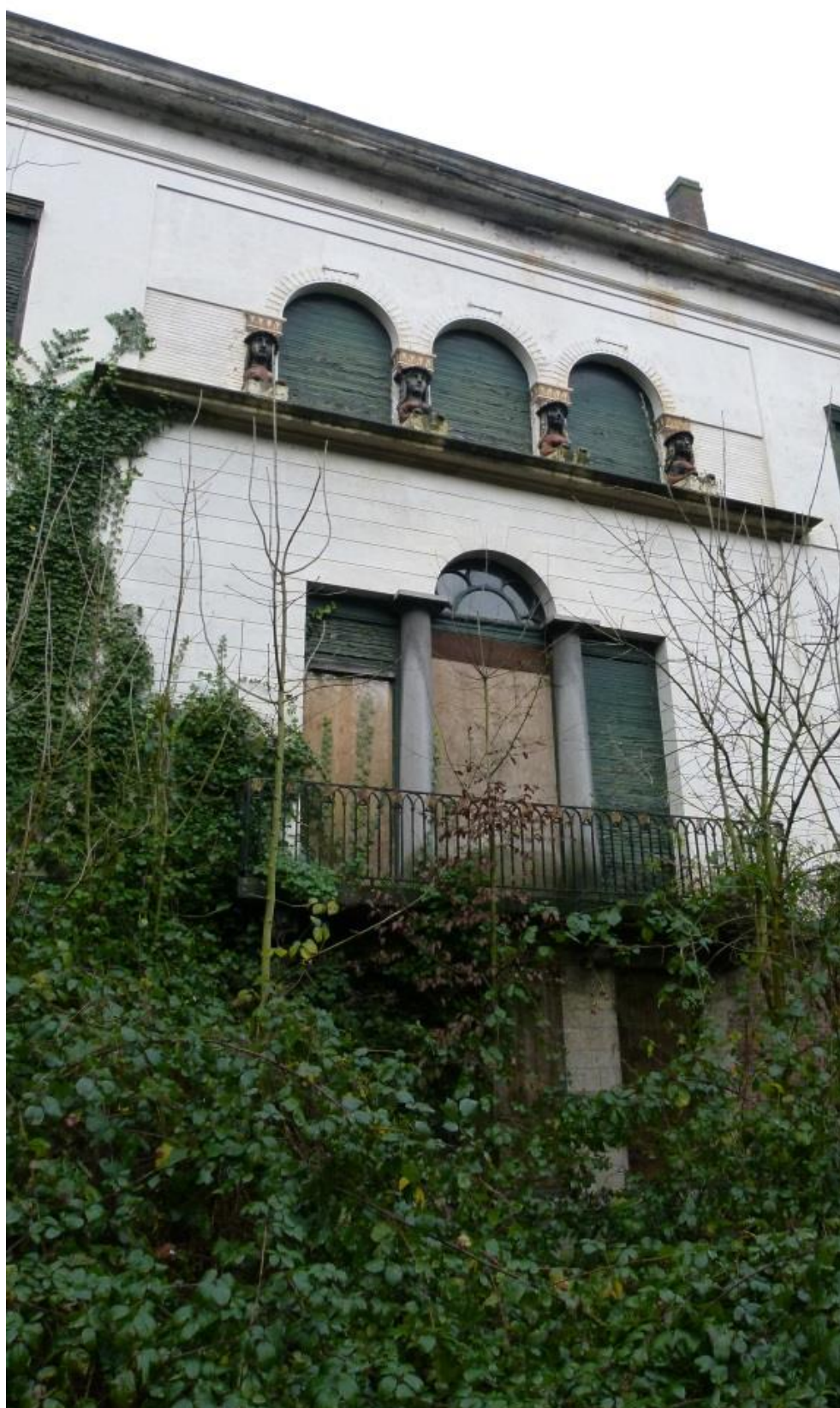
Figuur 7: Bestaande toestand van de achtergevel
