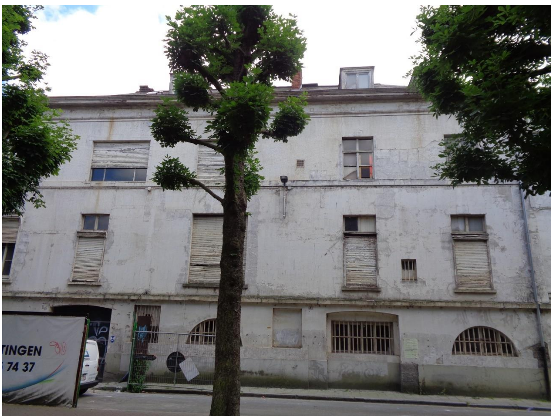
Figuur 5: Bestaande toestand van de voorgevel
