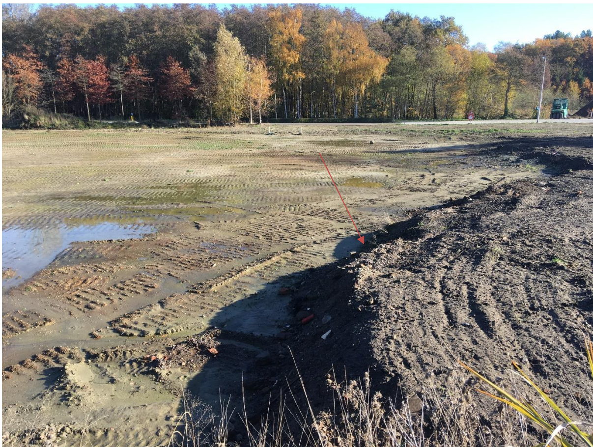
Figuur 26: Hoogteverschil waarneembaar ter hoogte van het toekomstige RWZI (ABO 2018). De foto is genomen richting de Nijverheidsweg (oosten) op 14 november 2018 (ABO nv 2018).
