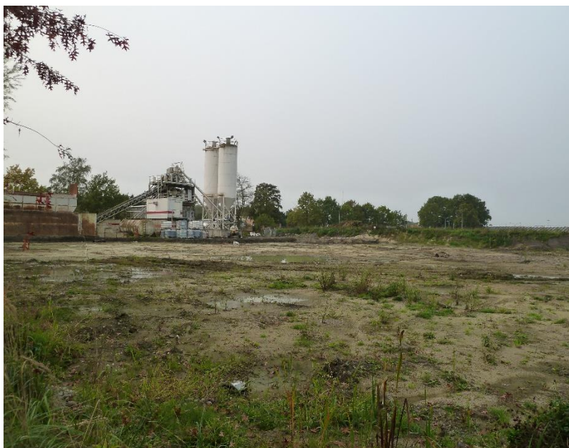
Figuur 6: Een foto van de mobiele breekinstallaties en een betoncentrale (Initiatiefnemer 2018). Deze zijn nu niet meer aanwezig op het onderzoeksgebied.
