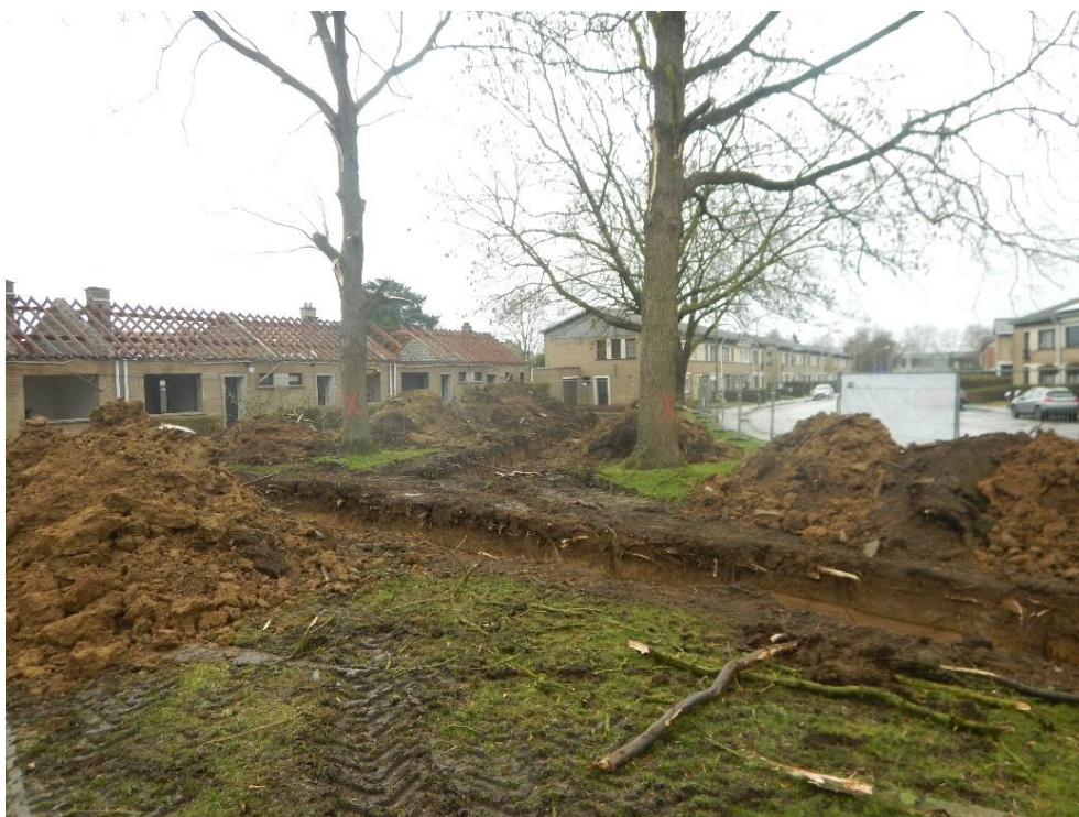
Figuur 6: Zicht op de aangelegde sleuven tussen de te behouden bomen.
