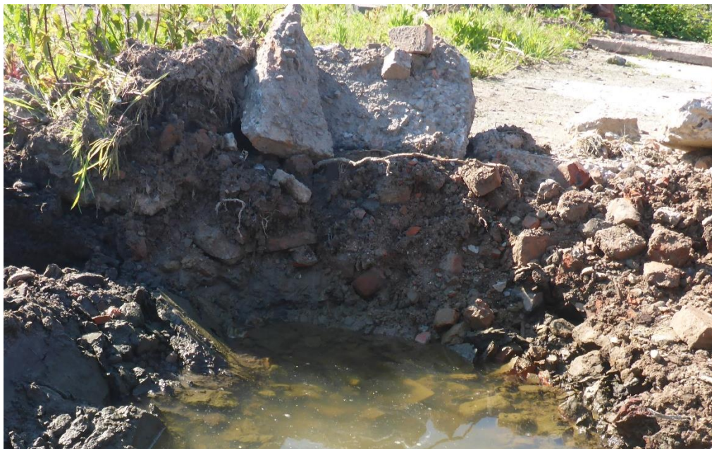
Figuur 29. Dik puinpakket onder de betonplaat. Dit profiel situeert zich tussen B3 en B4 aan de rand van de betonplaat
