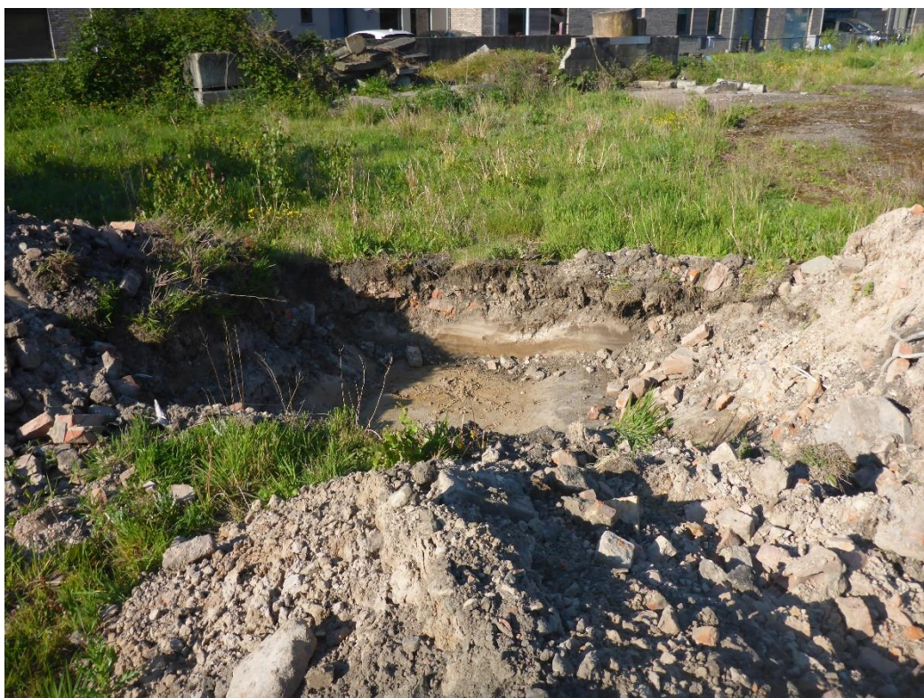
Figuur 26. zicht op een aangelegde testput, aangelegd bij de afbraakwerken
