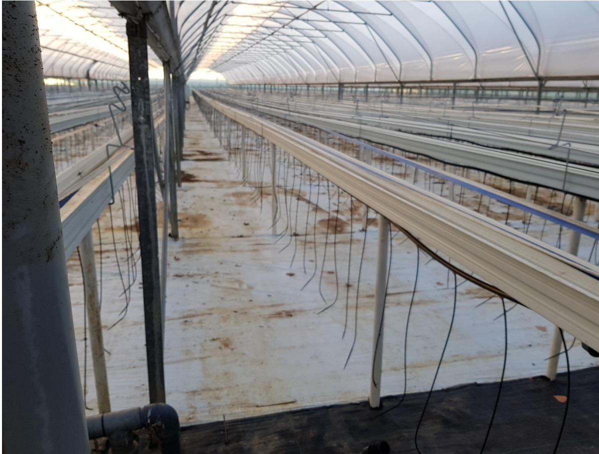
Figuur 1. Zicht op uitvoering tunnelbogen, bovenaan dikke palen die geboord worden
