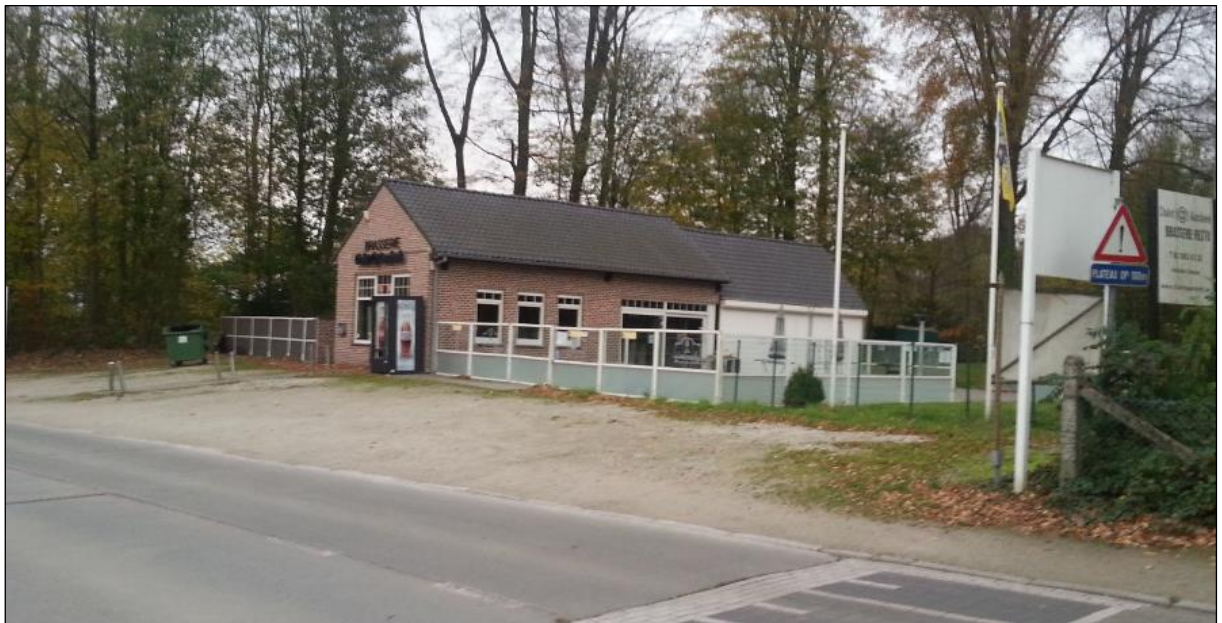
Figuur 4: Zicht op huidige gebouw vanuit de Kasteelstraat (bron: opdrachtgever).
