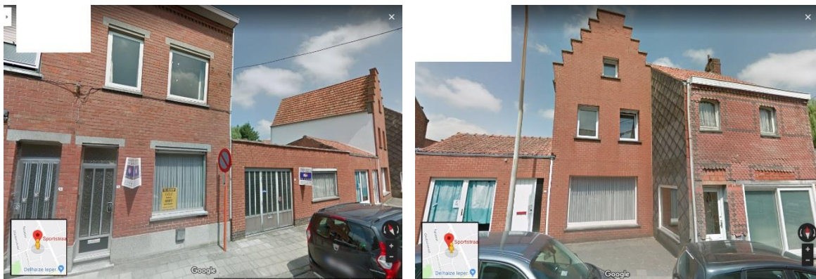
Figuur 1: Foto van zuidelijke rijbebebouwing langs de Sportstraat. 5
