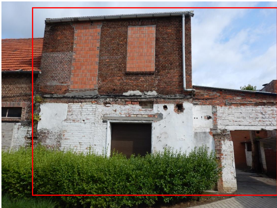
Fig. 13: de achtergevel van het gebouw
