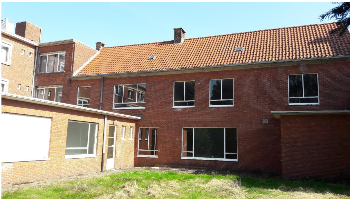
Figuur 6: Achtergevel Graatakker 6-8: detail 2 7
