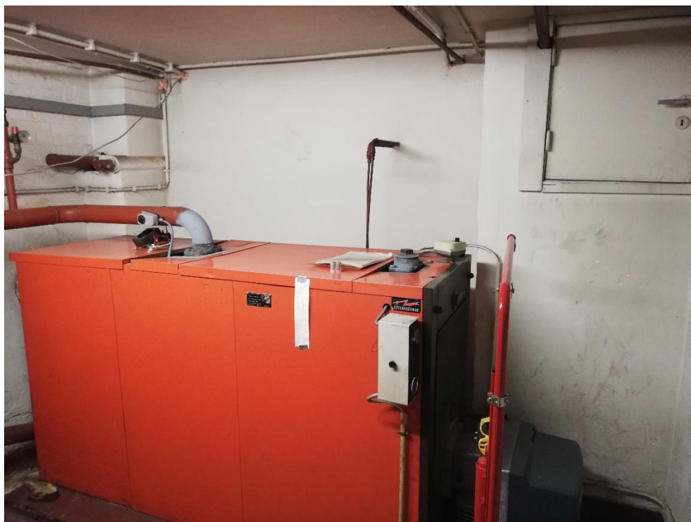
Figuur 30: Achterste kelder Graatakker 4 18
