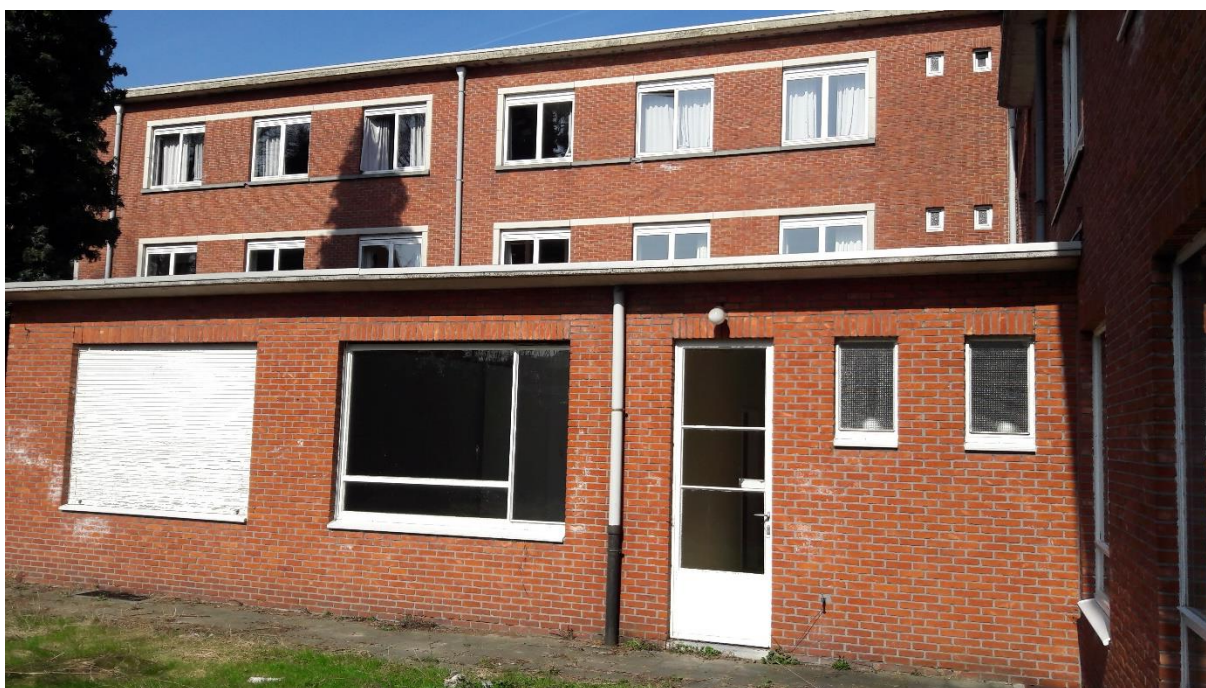
Figuur 7: Zijgebouw Graatakker 6-8 met daarachter zijgevel van Graatakker 4 8
