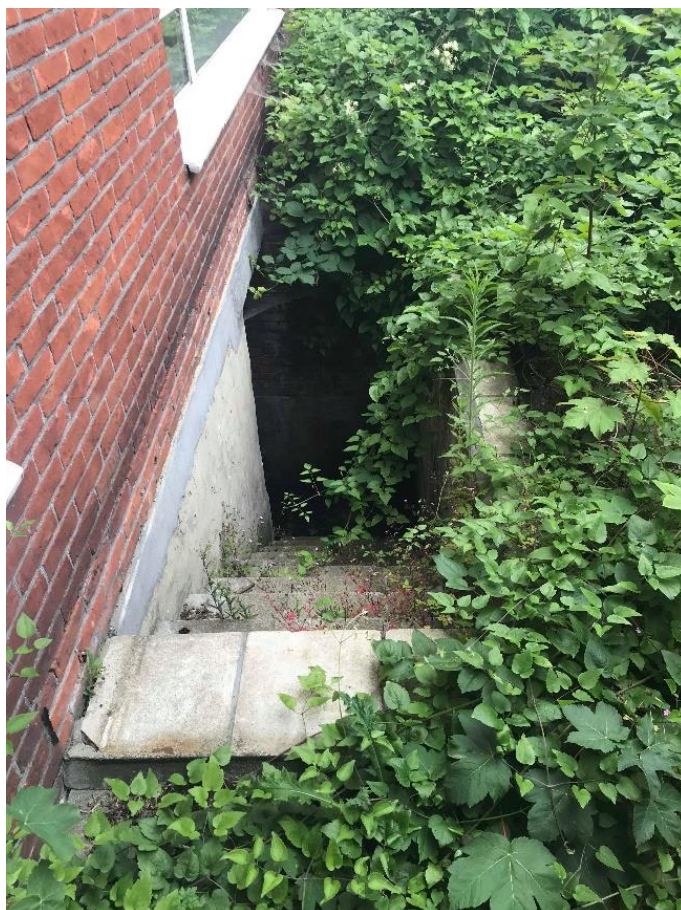
Figuur 19: Ingang kelder Graafakker 6-8 (Deze bevindt zich aan de achtergevel van het gebouw) (© J. Verrijckt bvba Archeologie & advies)
