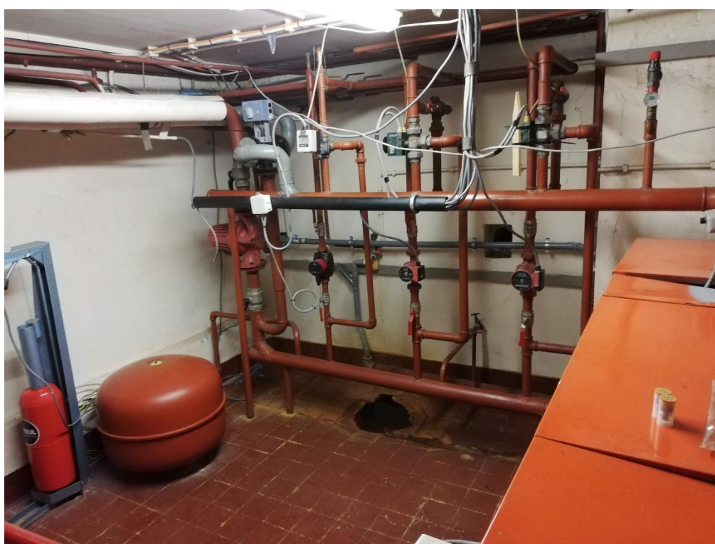
Figuur 31: Achterste kelder Graatakker 4 19
