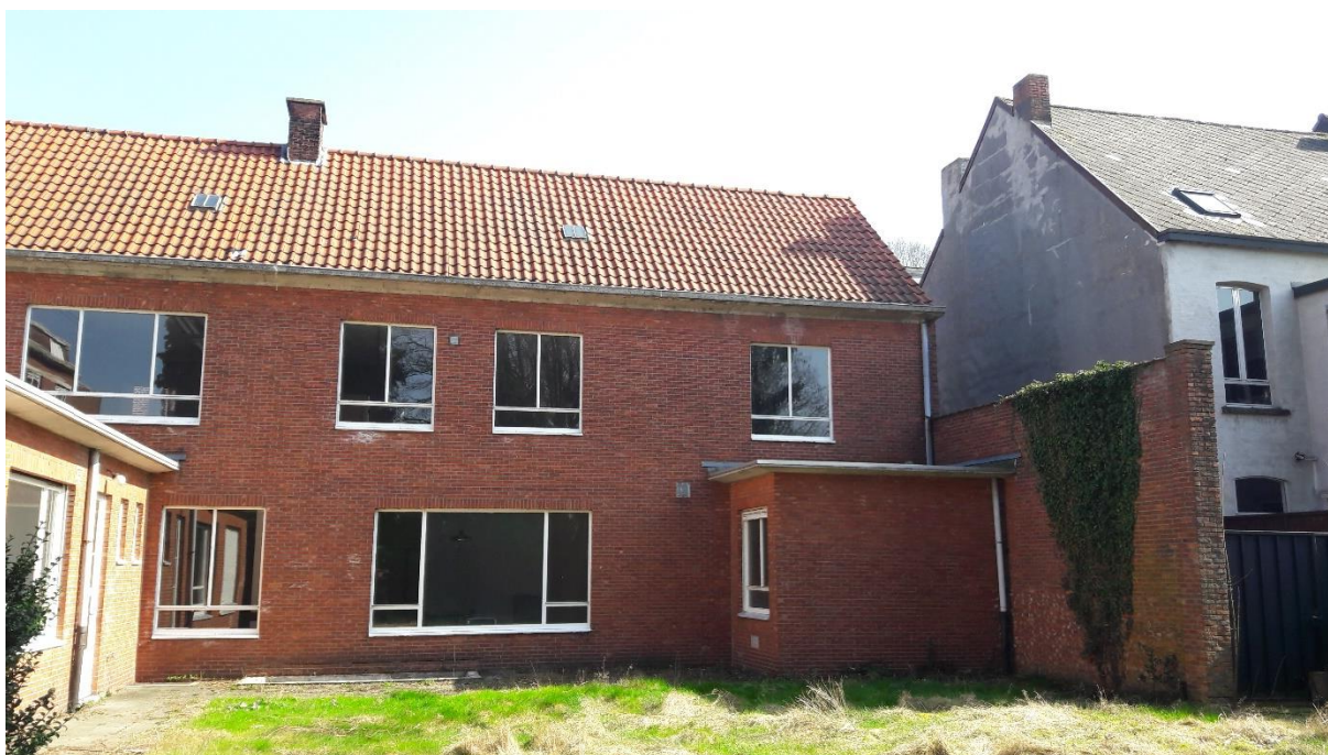
Figuur 5: Achtergevel Graatakker 6-8: detail 1 6
