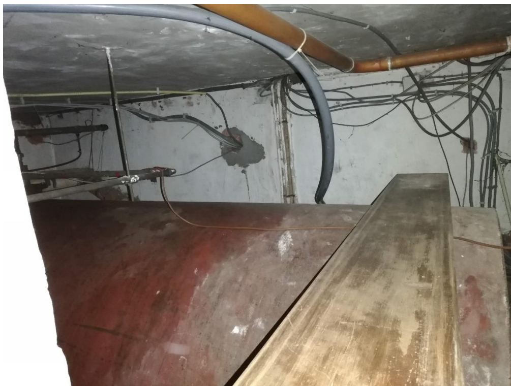
Figuur 32: Achterste kelder Graatakker 4 20
