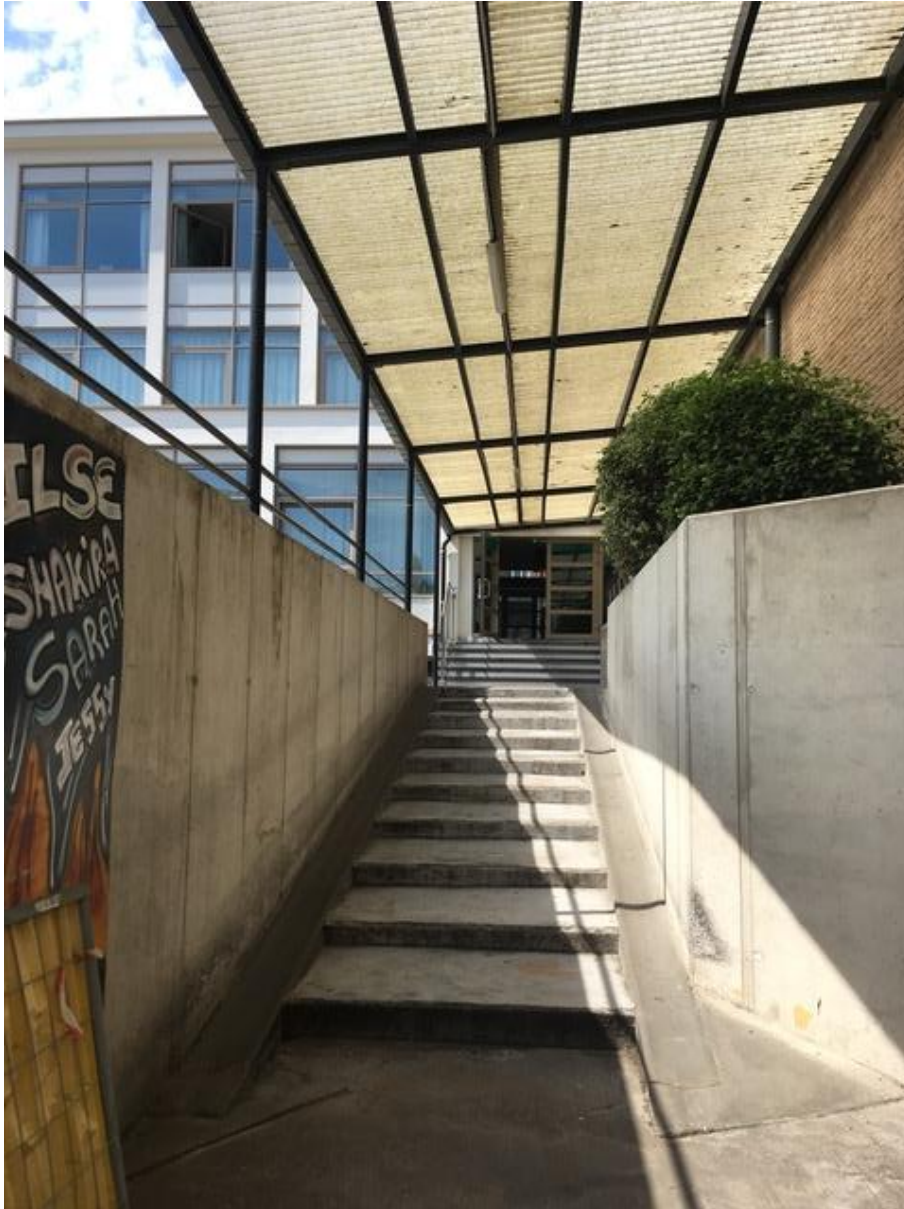
Figuur 5: Zicht op de toegangstrap tot de kelder (foto DG architecten bvba)
