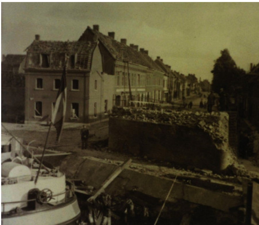
Figuur 2. Restanten van de vernielde Centrumbrug of Vaartbrug in 1940, in de richting van het Stationsplein
