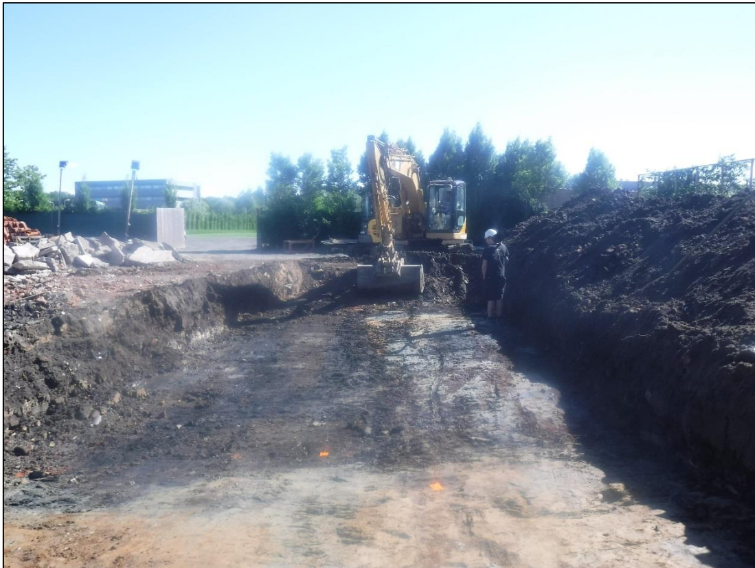
Figuur 4: Aanleg vlak 1, foto richting noorden
