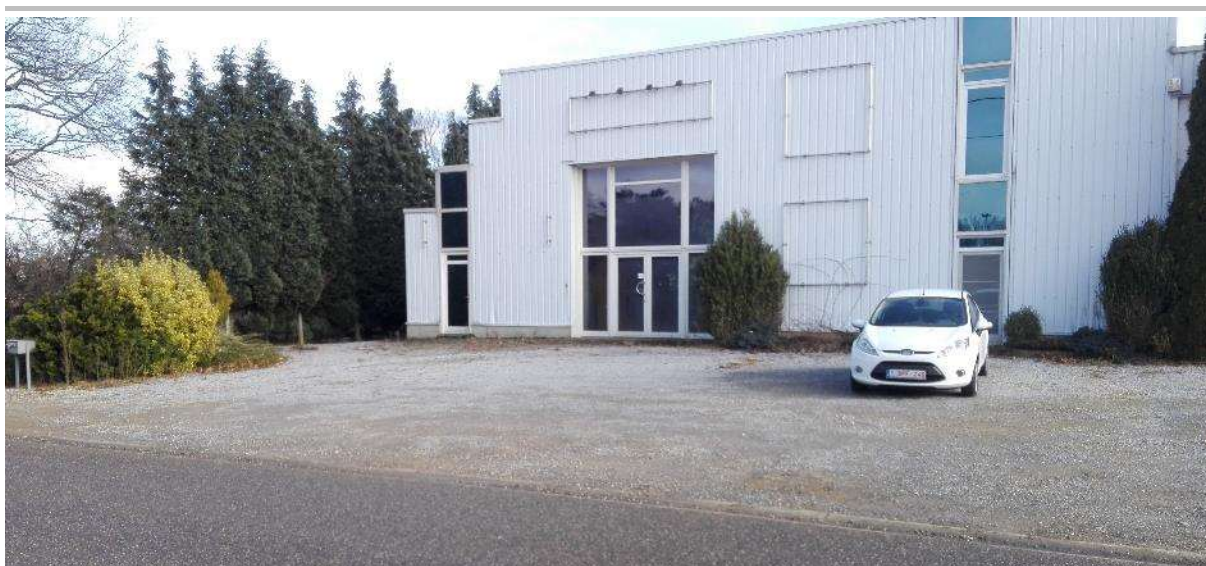
Fig. 2.5: Zicht op de westgevel van het bedrijfsgebouw.
