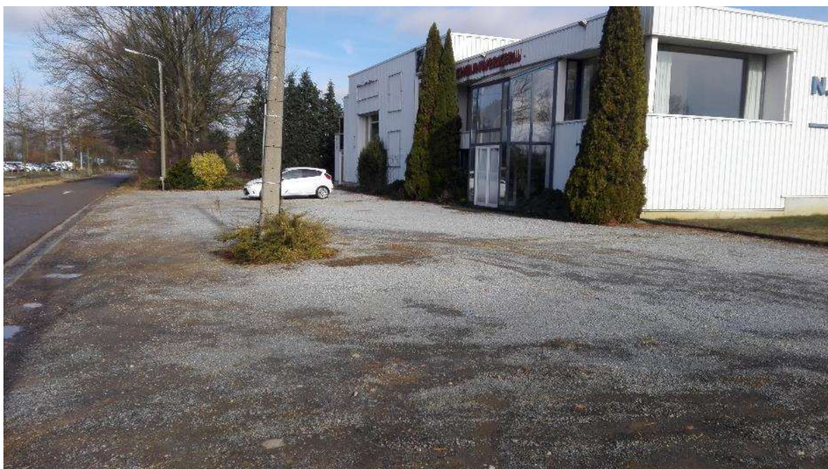
Fig. 2.6: Zicht op de hoek van de west-en zuidgevel van het bedrijfsgebouw.
