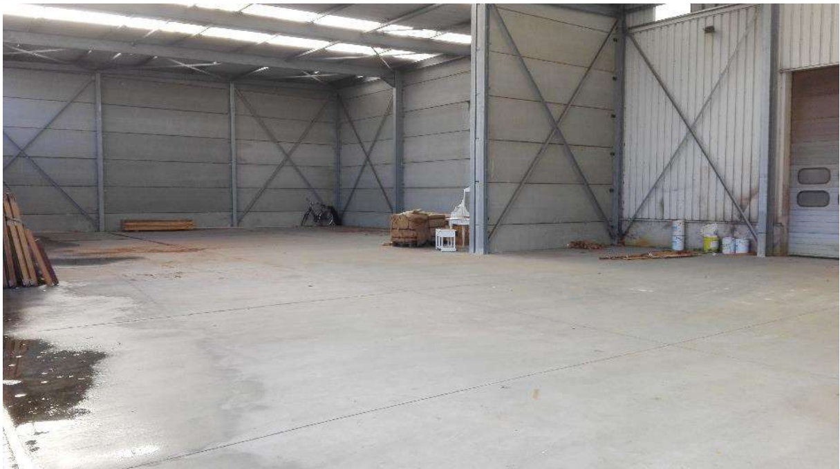
Fig. 2.16: Zicht op de binnenkant van het gebouw. Foto getrokken vanuit de poort in de oostelijke gevel.
