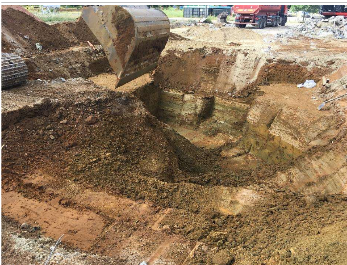
Fig. 3.5: Overzichtsfoto van de saneringswerken (sleuf 5) op 5 juli 2019.
