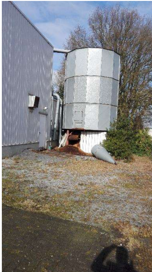
Fig. 2.15: Zicht op de noordoostelijke hoek van de oostgevel en de silo.
