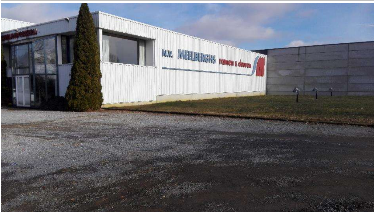
Fig. 2.7: Zicht op de hoek van de west- en zuidgevel van het bedrijfsgebouw met grasveld.
