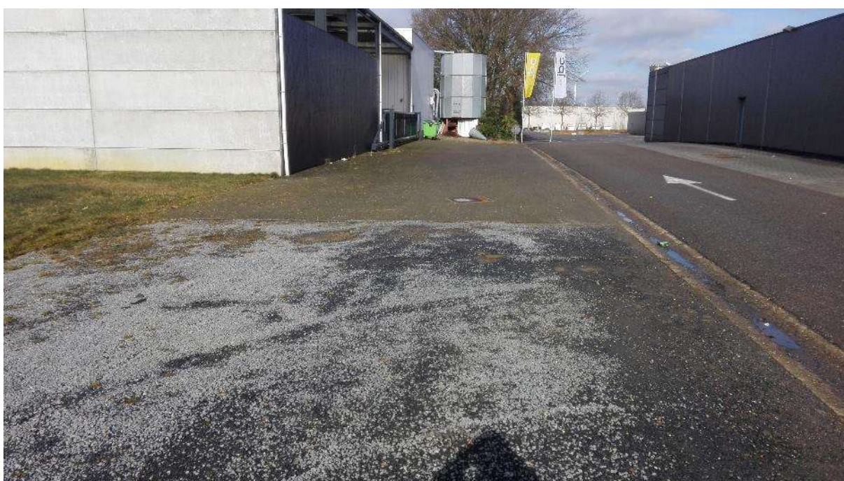
Fig. 2.14: Zicht op de hoek van de zuid- en oostgevel en de klinkerverharding. In de oostelijke gevel is een toegang naar het gebouw via een poort.
