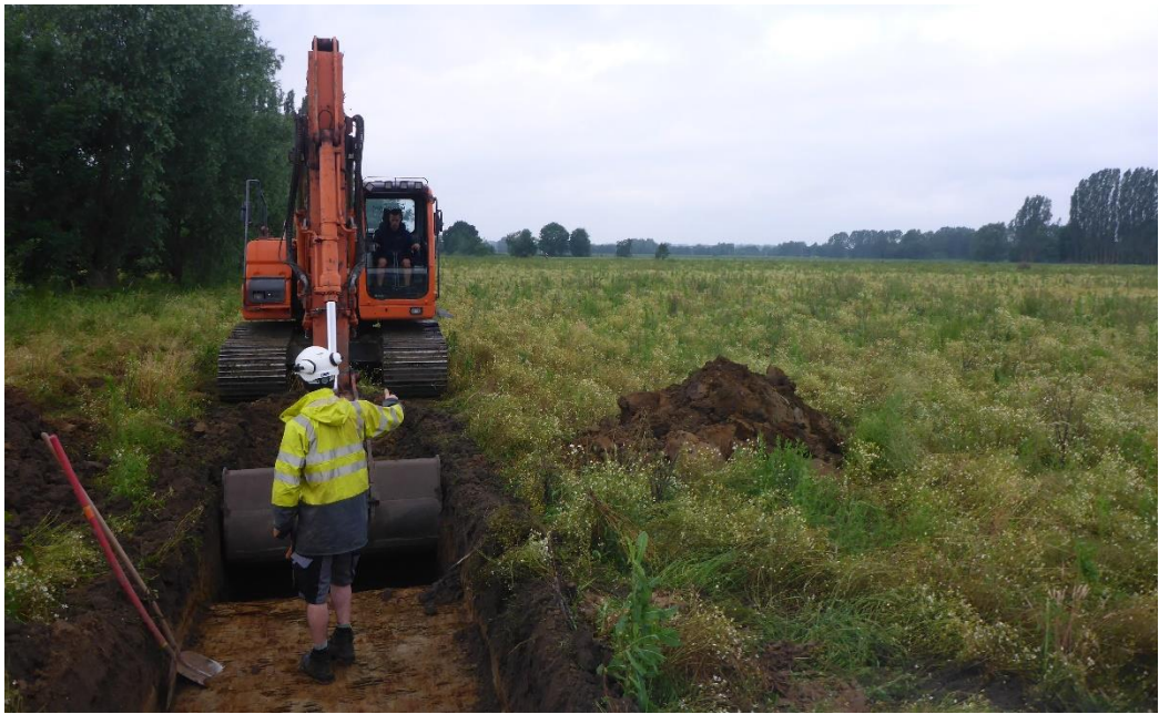
Figuur 5 Aanleg van werkput 1 (GATE)
