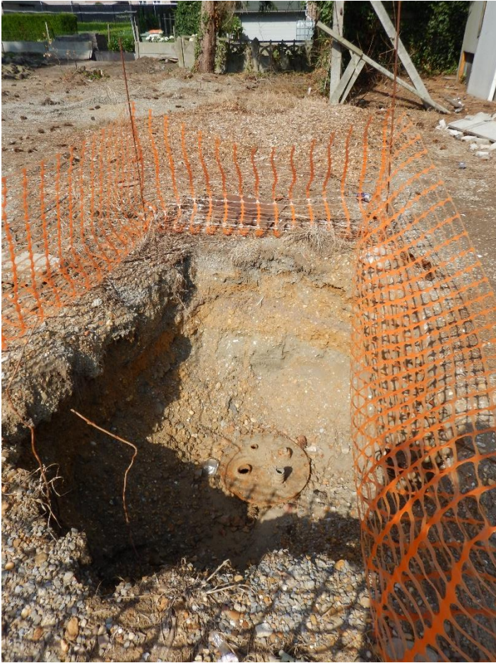
Fig. 6: de ondergrondse tank horend bij het complex aan de Weg naar Zwartberg
