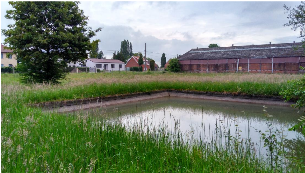
Afb. 5. Waterbassin in deelgebied 2.
