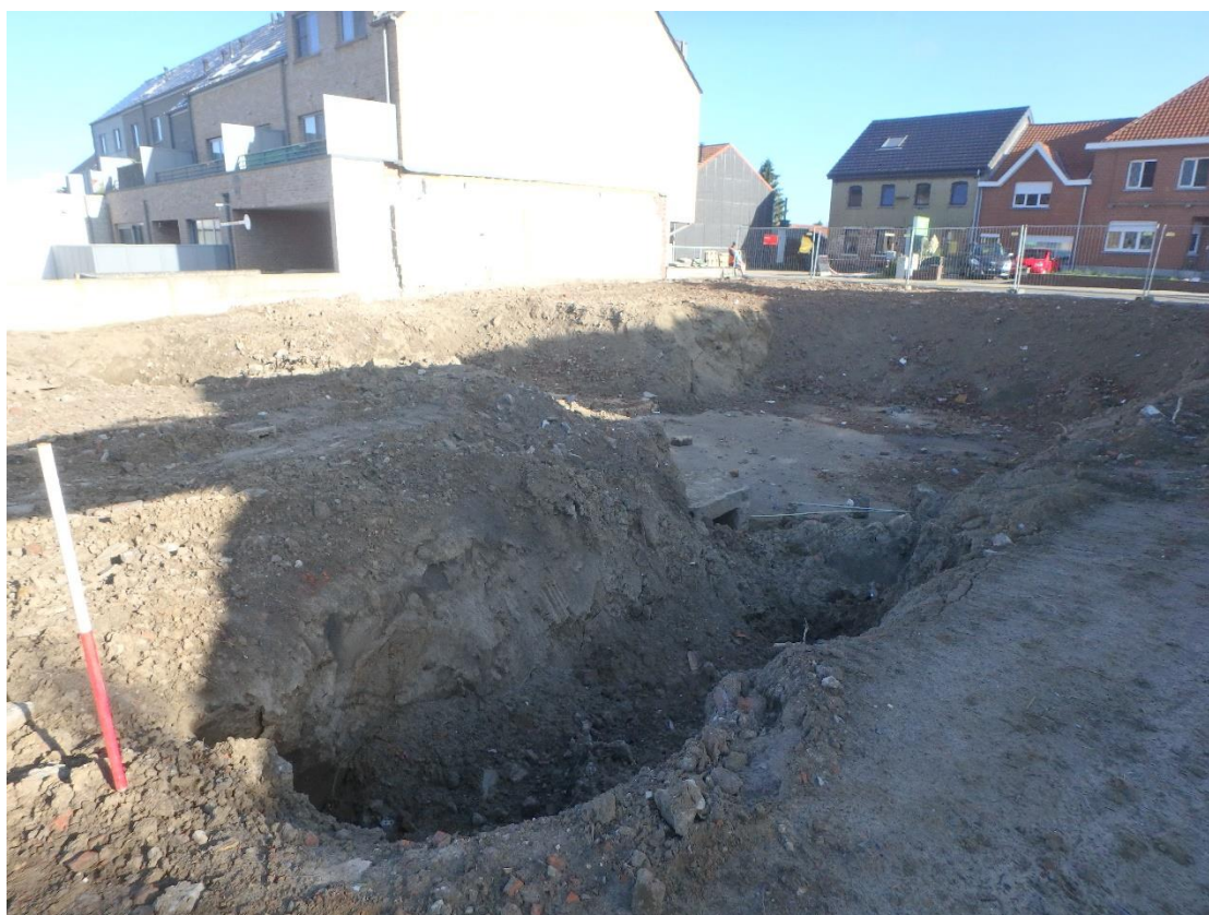
Figuur 6: Zicht vanuit het zuidoosten op de kelder (achtergrond) en de locatie van één van de uitgegraven mazouttanks (voorground). © Devroe bvba 2019
