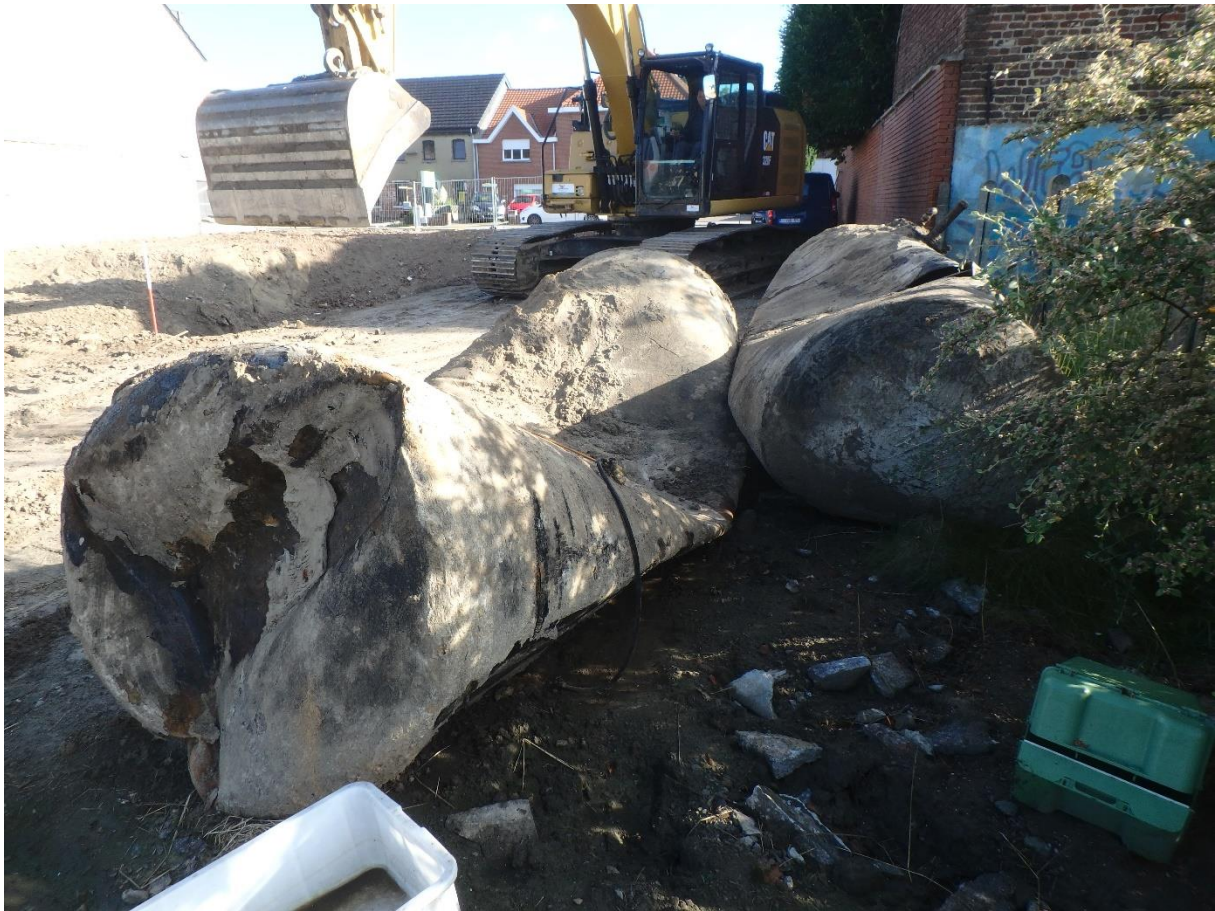
Figuur 7: De twee uitgehaalde mazouttanks lagen tegen de oostelijke perceelsgrens. © Devroe bvba 2019
