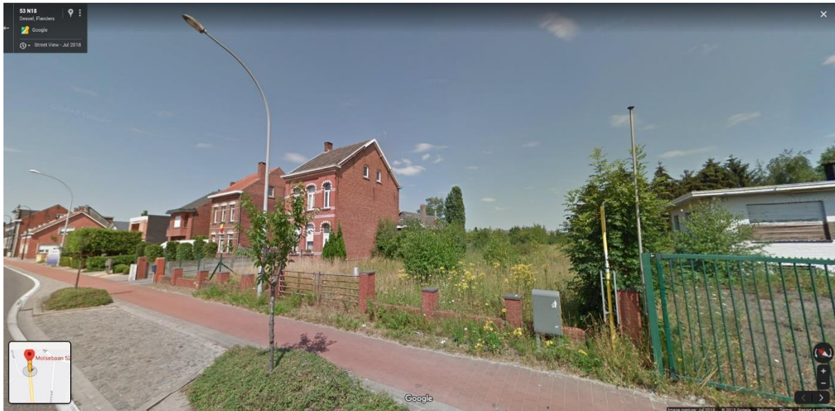
Figuur 1: Zicht vanop de Melsebaan op het woonhuis (l.) en het bureau (r.) 6
