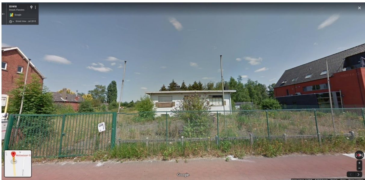
Figuur 2: Zicht vanop de Melsebaan op de bureauruimte. 7
