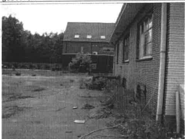
Foto9: nagaan of elektrische kabels buiten dienst zijn en of de regenafvoer (dak) dient te worden verzekerd tijdens de graaf- en saneringswerken. (gebouw wordt afgebroken? Voor, tijdens of na de saneringswerken?)
