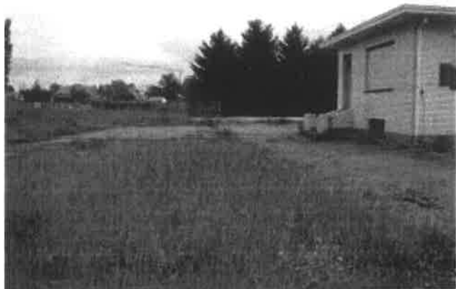
Foto7: aandacht voor al of niet beschermen van bomen en planten, stabiliteitsmaatregelen tgv betonnen omheiningen, gebouw,...
