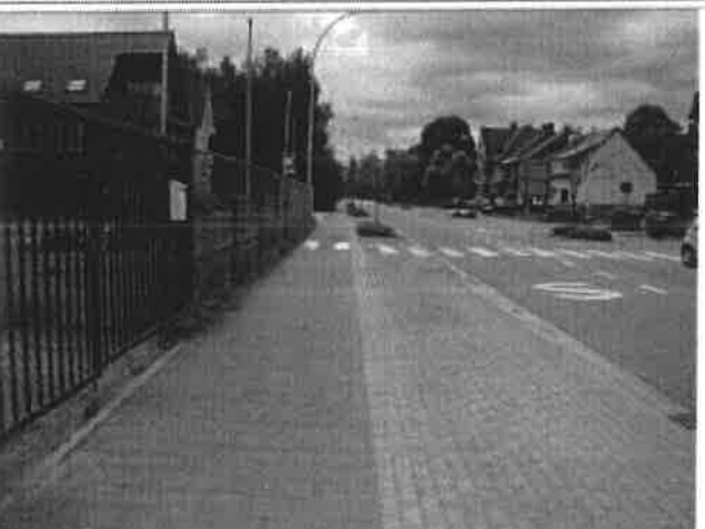
Foto5-6: duidelijk aandacht voor in- en uitgaand verkeer! Waarschuwborden tvv fietsers, voetgangers, bushalte, auto's maar ook tvv intern transport. Beschermen van de bestaande poort, omheining, signalisatieborden, tuilmuren,... en de fiets- en voetpaden en wegdek dmv rijplaten, rubberen matten,...
