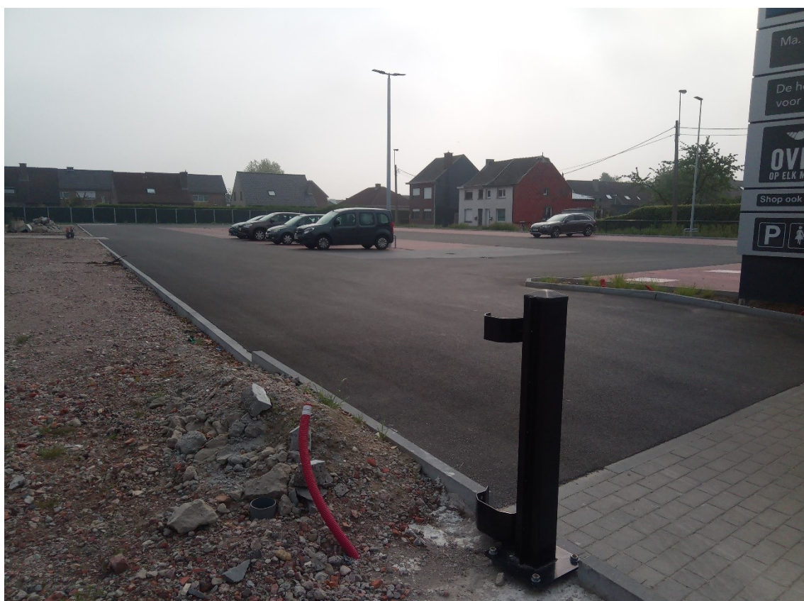
Figuur 6: Foto van het zuidoostelijke deel van het terrein dat ingericht is als parking
