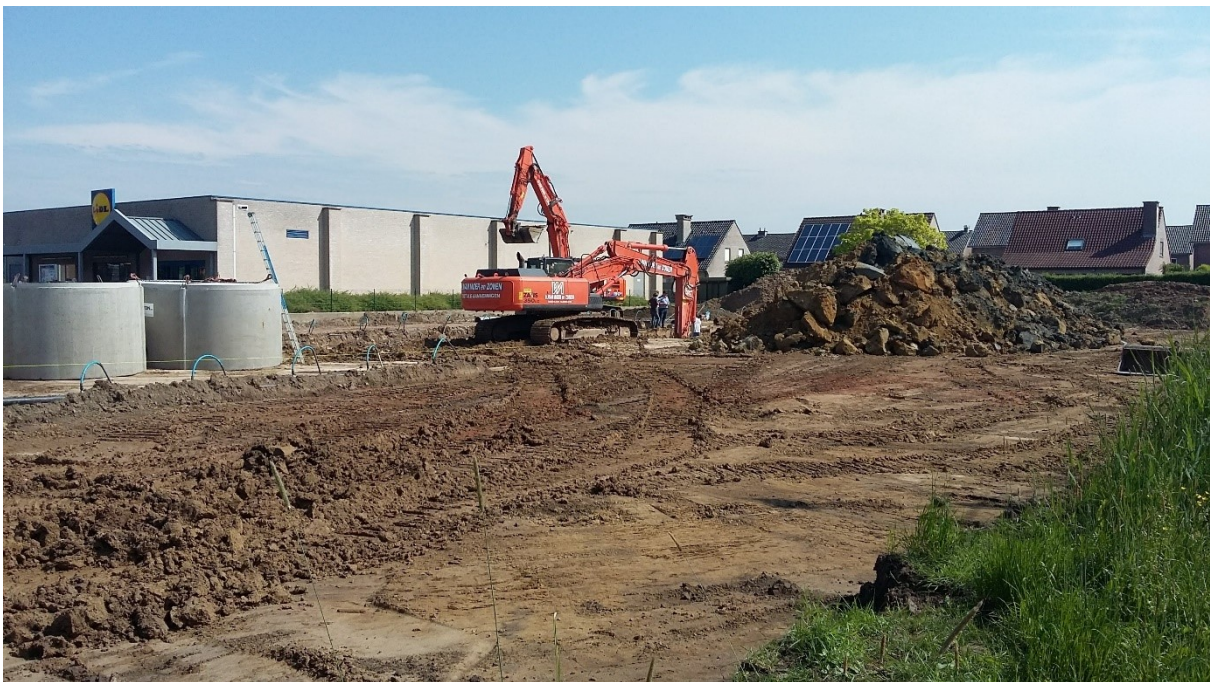
Figuur 4: Afgraving van het terrein en plaatsen van de putten in het zuidelijke deel van het onderzoeksgebied
