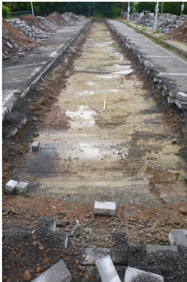
Figuur 5: Zicht op sleuf na het uithalen van de klinkers en de bovenste stabilisélaag (bron: Abo nv, 2019)
