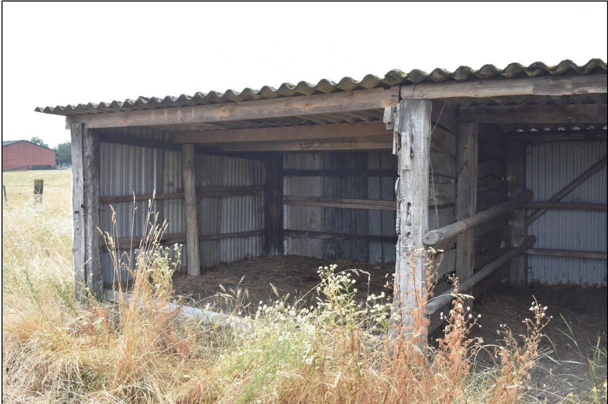
Afb. 35: Recente veestal met paalconstructie op het onderzoeksgebied.
