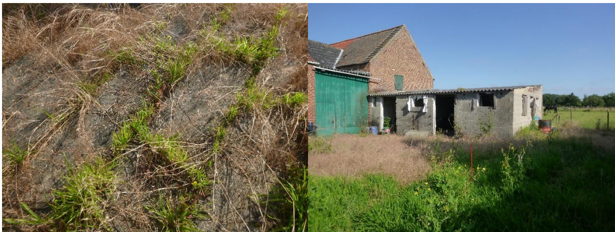
Figuur 4: Betonnen vloer van het hof (links); locatie boring 4 net op de grens van het verharde oppervlakte (rechts)
