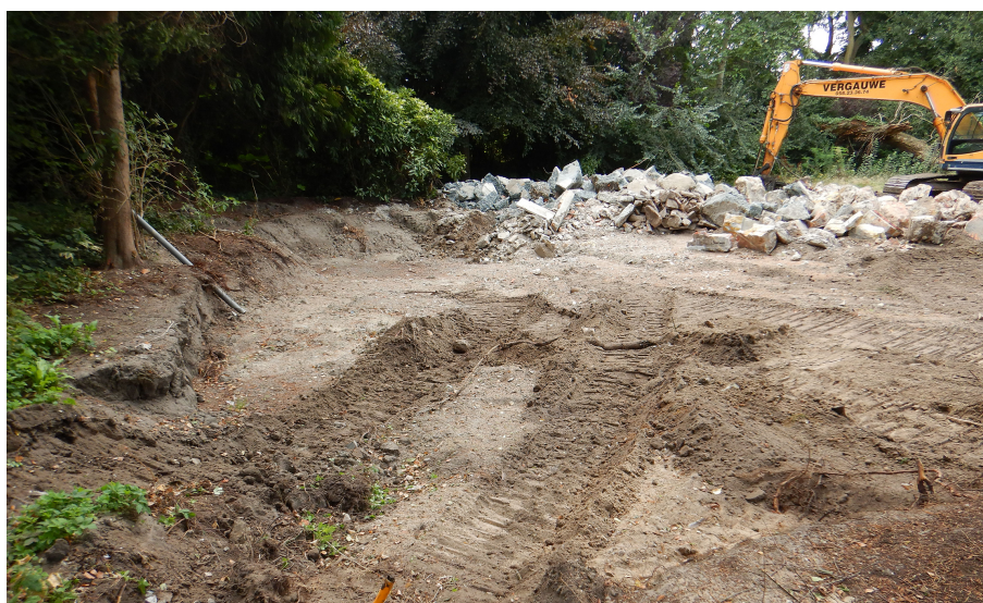
Figuur 4. De woning voor en na de sloop.
