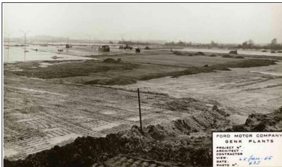
Figuur 8: Afgraving- en nivelleringswerkzaamheden op de site in januari 1966. 21
